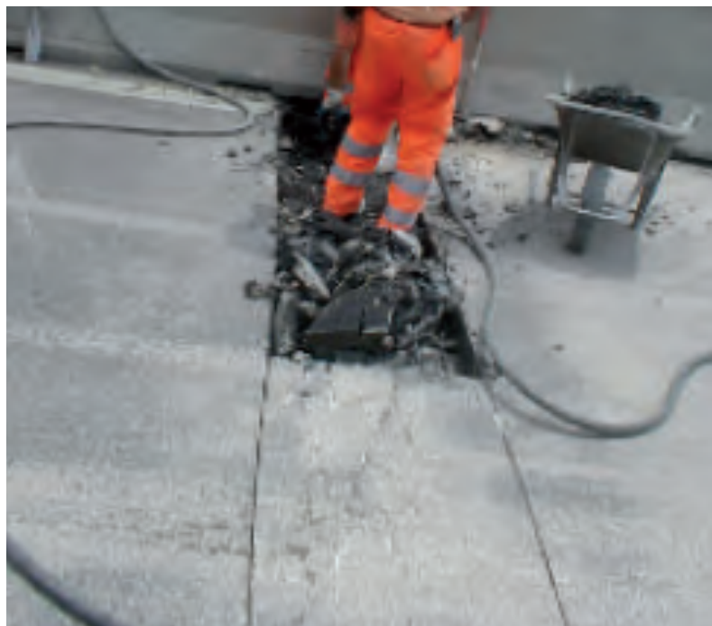
Figura 107 - Taglio preliminare della pavimentazione stradale
