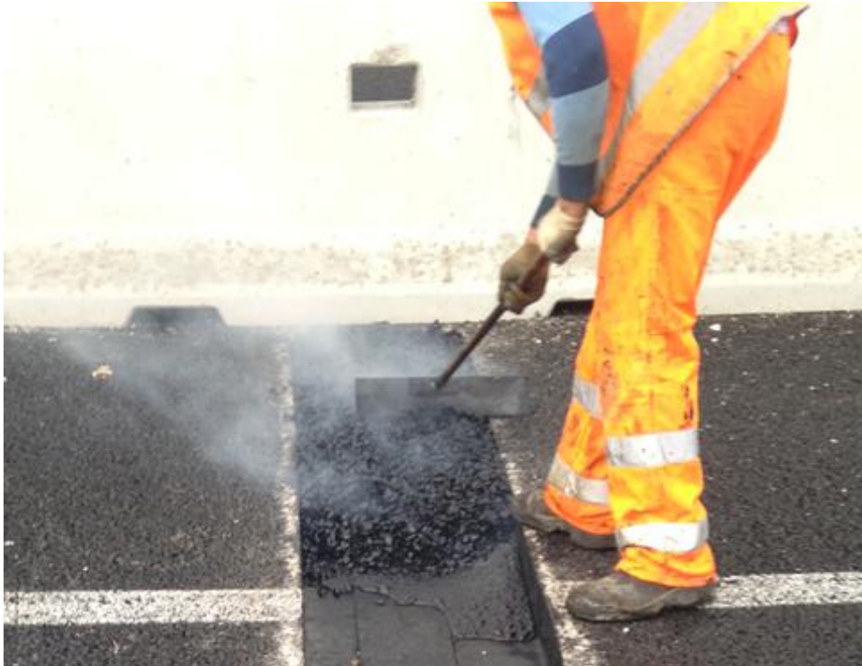
Figura 108 - Posizionamento dell'aggregato scaldato
