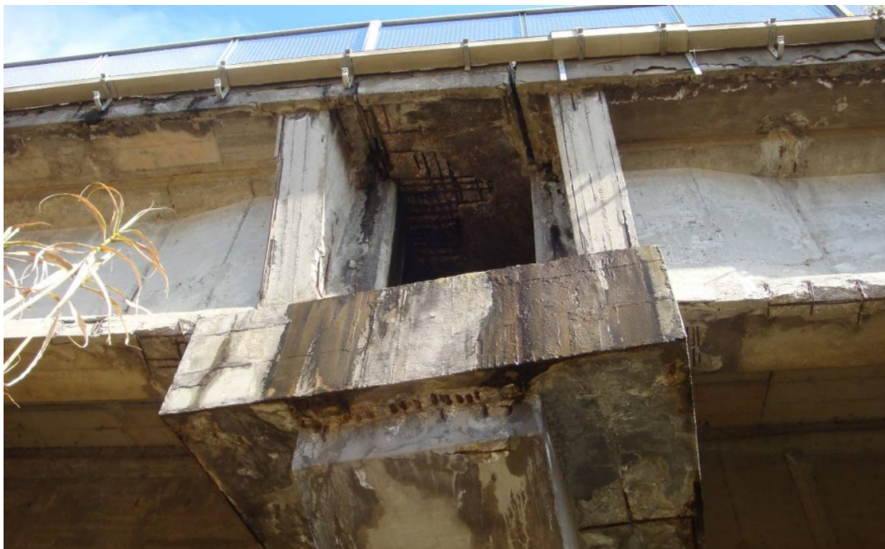
Figura 85 - Ammaloramento del pulvino
