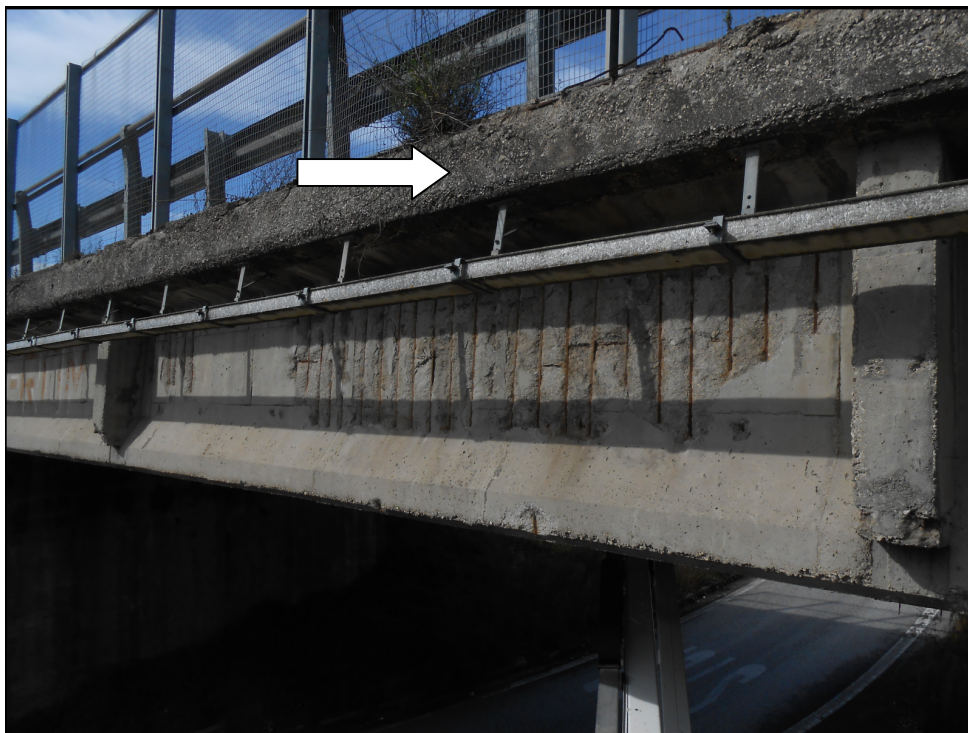
Figura 1 - Individuazione del cordolo bordo-ponte
