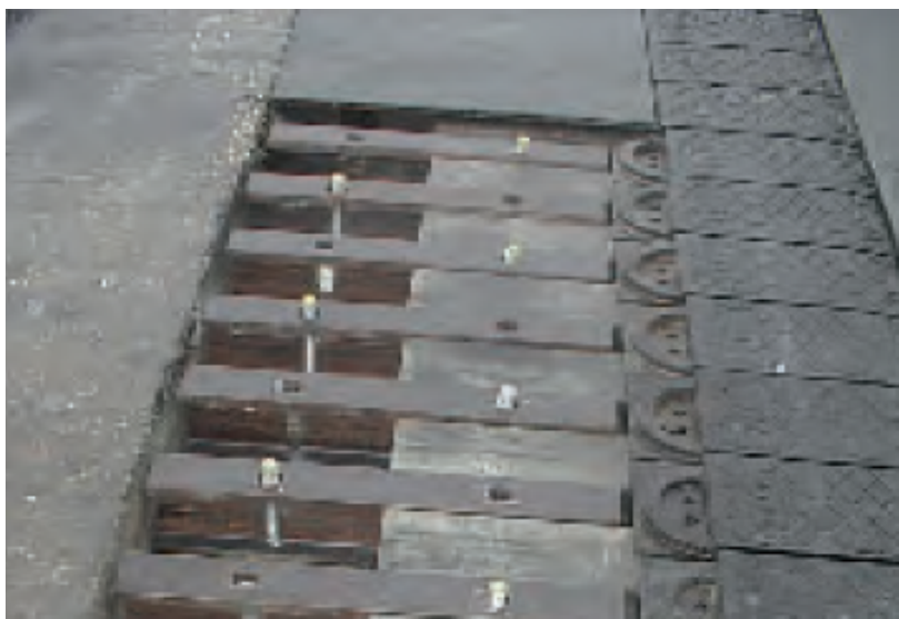
Figura 111 - Sostituzione dei bulloni di ancoraggio
