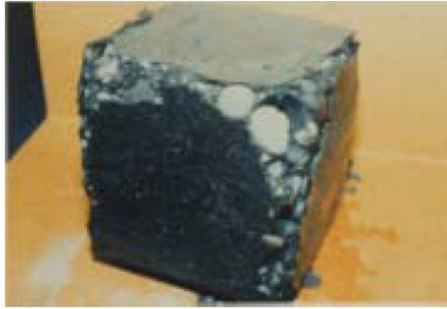
Figura 49 – Degrado del calcestruzzo per effetto del cloruro di calcio [8]
