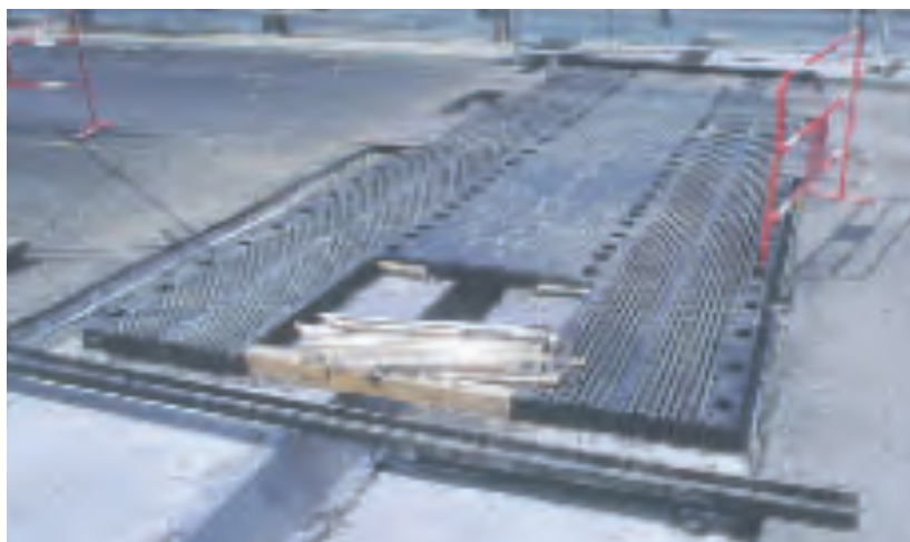
Figura 113 - Posizionamento dei moduli
