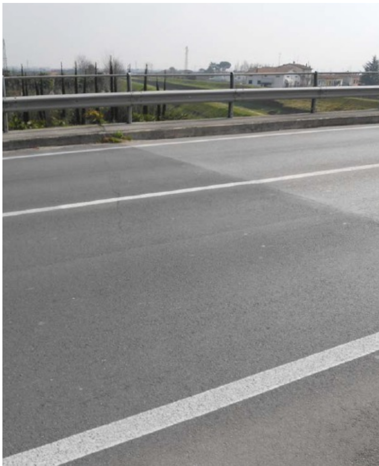
Figura 93 - Giunto di sottopavimentazione
