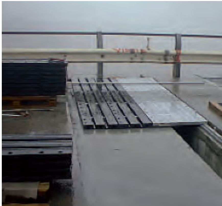
Figura 98 - Giunto a piastra ponte
