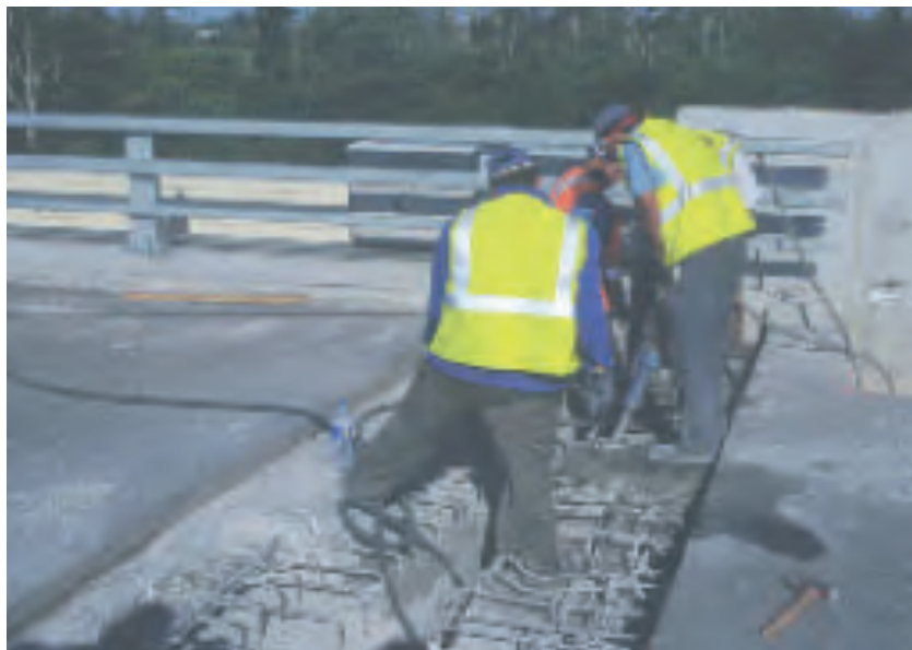
Figura 112 - Riparazione delle zone terminali delle solette
