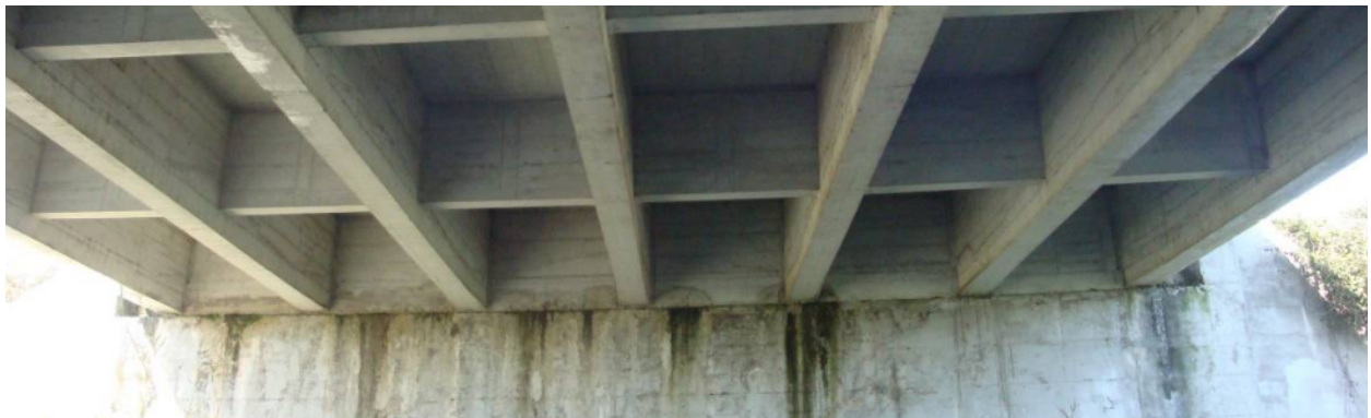
Figura 83 - Vista intradosso impalcato
