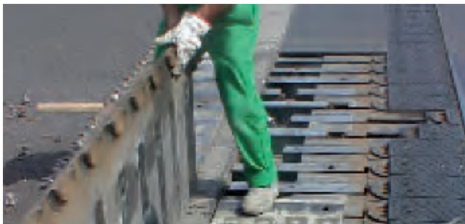
Figura 110 - Sostituzione di un modulo
