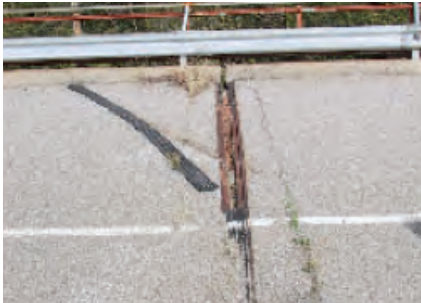
Figura 102 - Ammaloramento del giunto
