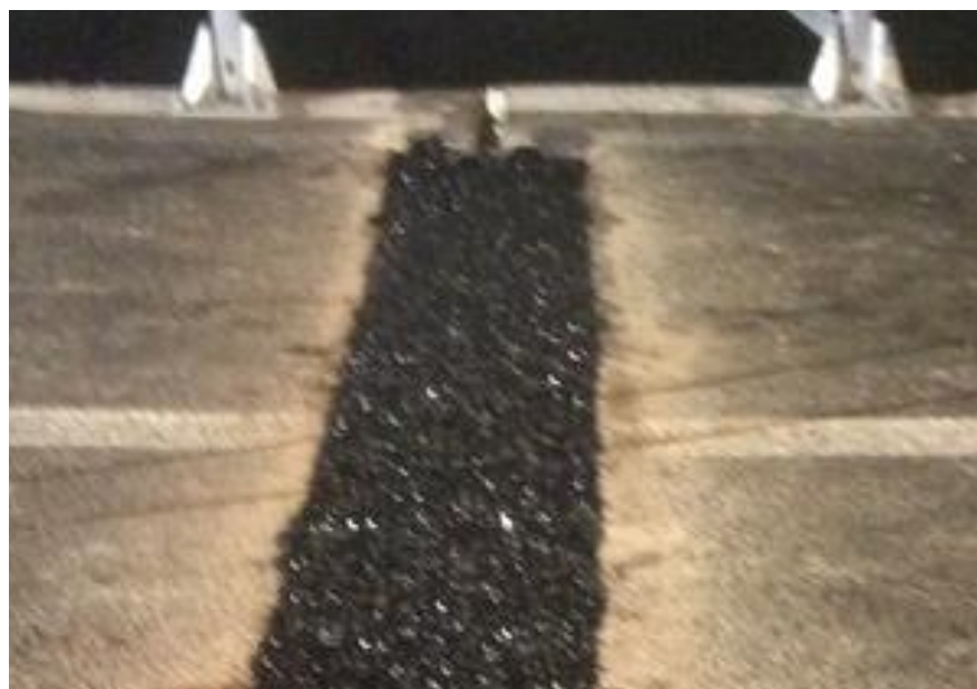
Figura 95 - Giunto a tampone viscoelastico
