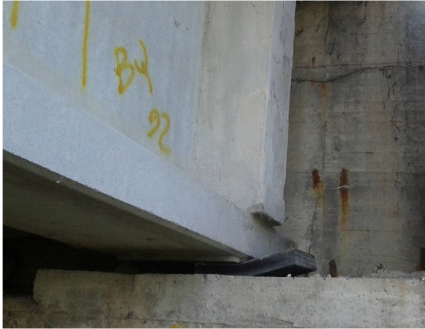
Figura 75 – Scivolamento dell'appoggio elastomerico
