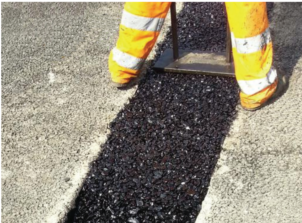
Figura 109 - Fase di compattazione dello strato di copertura
