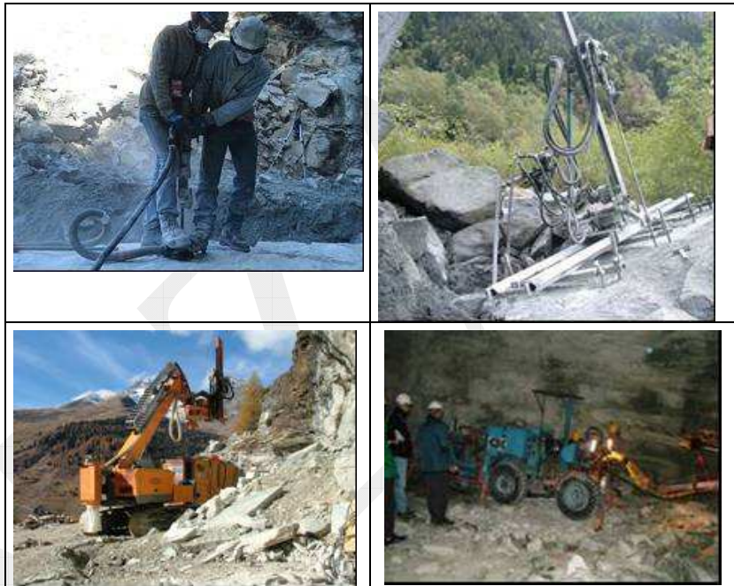
Fig.1: Perforazione con perforatrici manuali e meccaniche a secco e ad umido
