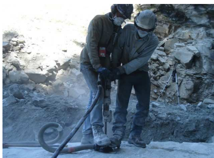
Fig.1-2-3: Perforazione manuale classica e con aspirazione a boccaforo
