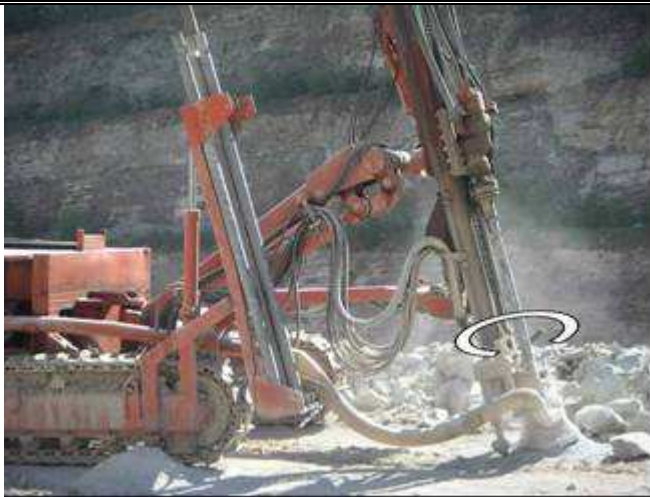
Fig.2: Perforatrice con aspirazione a boccaforo
