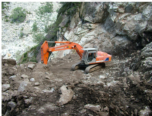
Fig. 1: Preparazione e manutenzione sito di cava
