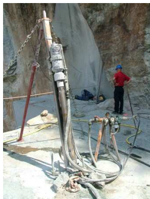
Fig.1: Perforatrice con spurgo d'acqua
