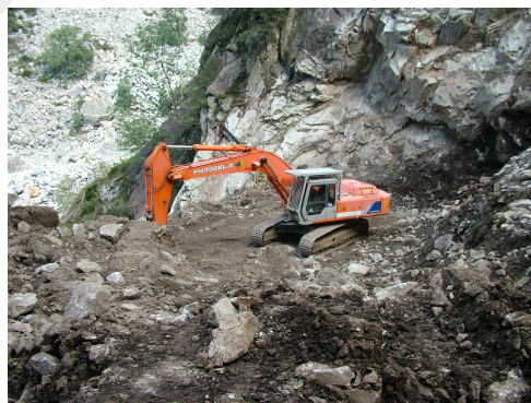
Fig.1: Preparazione e manutenzione sito di cava
