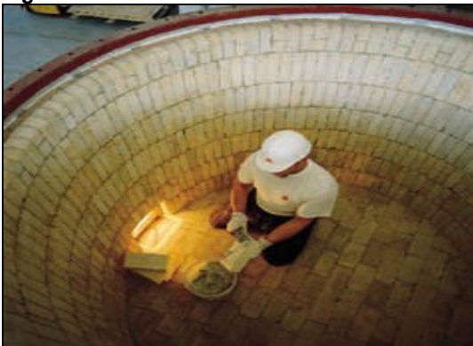
Fig.1 – Rifacimento refrattario
