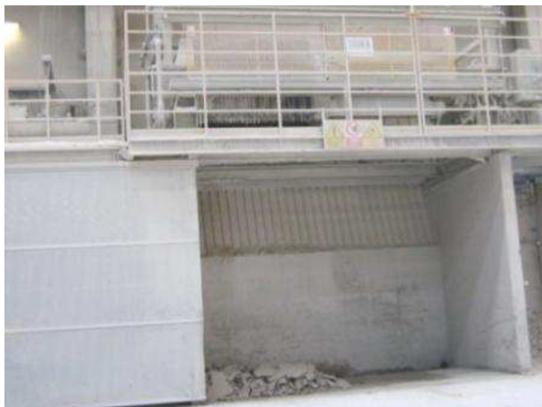
Stoccaggio degli scarti crudi in box con porta scorrevole, alimentazione e aspirazione nel soffitto del box
