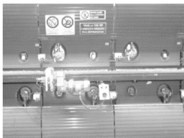
Carteratura dei rulli e degli organi meccanici, schermi termici, segnali di pericolo.
