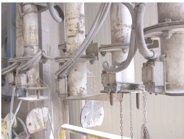
Particolari: gli agganci per lo scarico pneumatico e il microcontatto del circuito di controllo.
