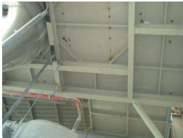
Sigillatura del piano di calpestio della pensilina.
