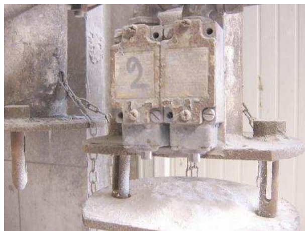
Particolari: gli agganci per lo scarico pneumatico e il microcontatto del circuito di controllo.
