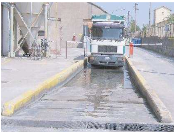
Sistema di pulizia ad umido delle ruote
