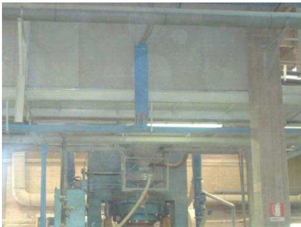
Segregazione laterale della pensilina.
