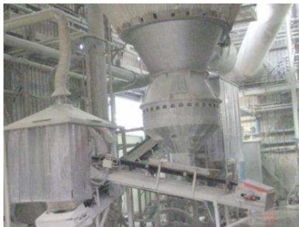
Anello raffreddatore e cappa aspirata con bandelle
