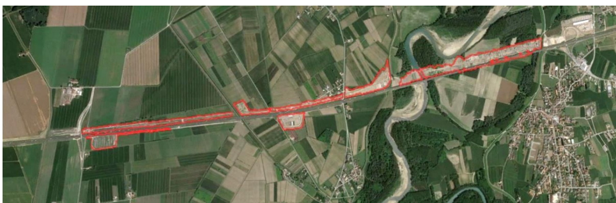
Figura 57 - Il tratto dell'autostrada A4 Torino-Trieste che attraversa il territorio di San Michele al Tagliamento dove, nell'ultimo anno, sono stati artificializzati quasi 34 ettari di suolo naturale, 22 dei quali per questa nuova grande opera.
