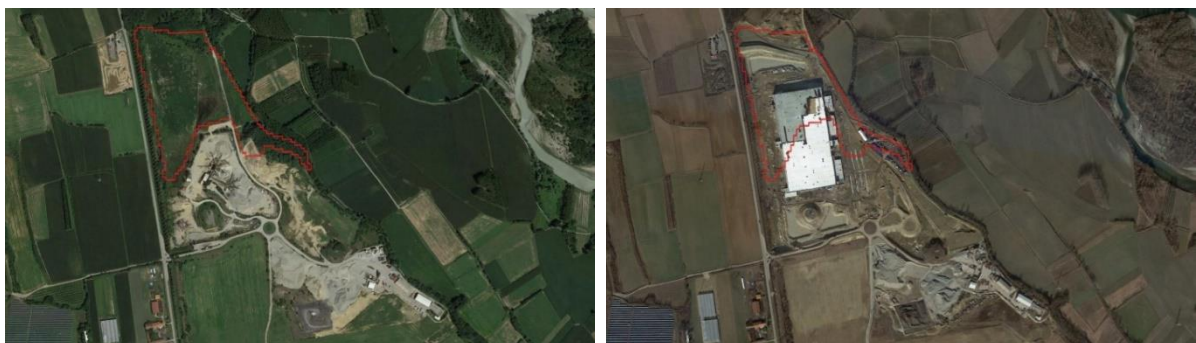
Figura 30 - Realizzazione di un nuovo centro per la logistica e lo smistamento merci, che unitamente alla costruzione di nuovi edifici residenziali, è responsabile di un incremento di suolo di 9 ettari nella piccola realtà urbana di Torrazza Piemonte, che si estende per 10 km 2 nella provincia di Torino.
