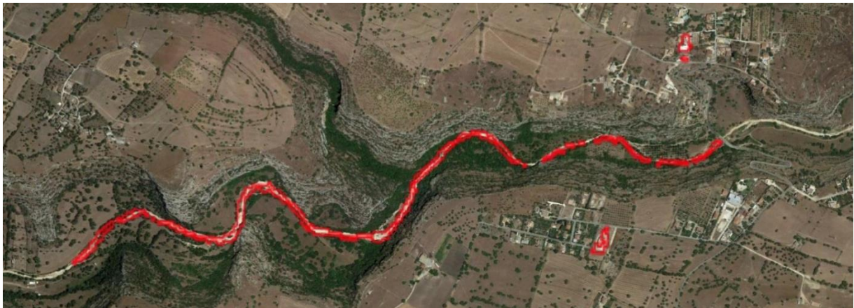
Figura 104 - Nel territorio provinciale di Siracusa, nel Comune di Rosolini, nell'ultimo anno rilevato, è possibile rintracciare un consumo di suolo di quasi 5 ettari, dovuto principalmente ad un'unità del primo lotto dei lavori finalizzati a raddoppiare e ampliare la Strada Provinciale 66 che dovrebbe congiungere Rosolini con Modica e Gela e ad alcuni interventi di edilizia residenziale.
