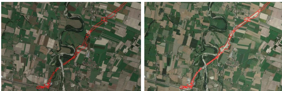
Figura 66 - Primo lotto della nuova arteria infrastrutturale Tirreno-Brennero, di 12 km, nel Comune di Sissa Trecasali (PR); il paese, di neanche 8.000 abitanti distribuiti su una superficie di quasi 73 km 2 , è il primo comune italiano per consumo di suolo nel 2017, con 74 ettari di suolo naturale persi. Sui 455 ettari totali che hanno perso la loro naturalità nella regione, 107 sono serviti per l'infrastruttura, mentre una superficie di quasi 115 ettari è frutto di una conversione da aree agricole a industriali o commerciali.
