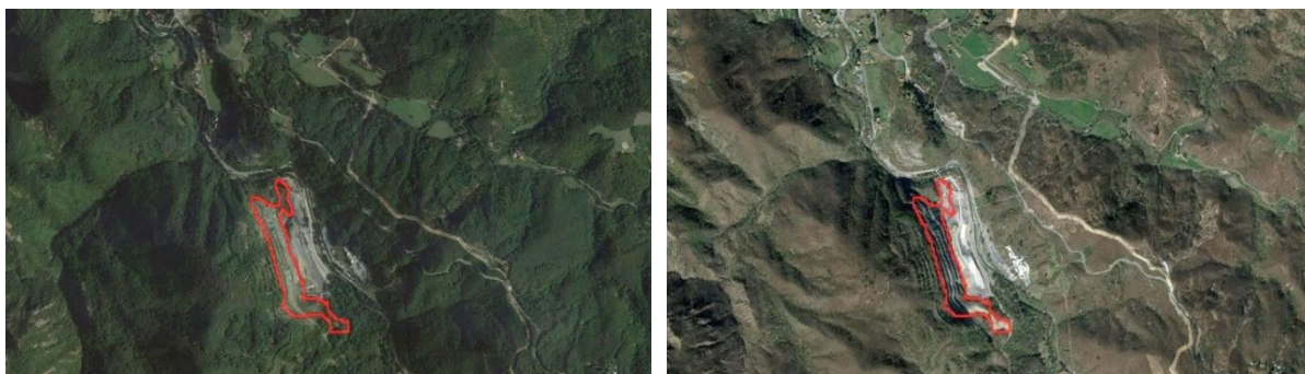
Figura 31 - Cantiere per la realizzazione del Terzo Valico nella Val Lemme, si inserisce nel computo dei 12 ettari incrementali registrati tra il 2016 e 2017 nella realtà di Voltaggio in provincia di Alessandria.
