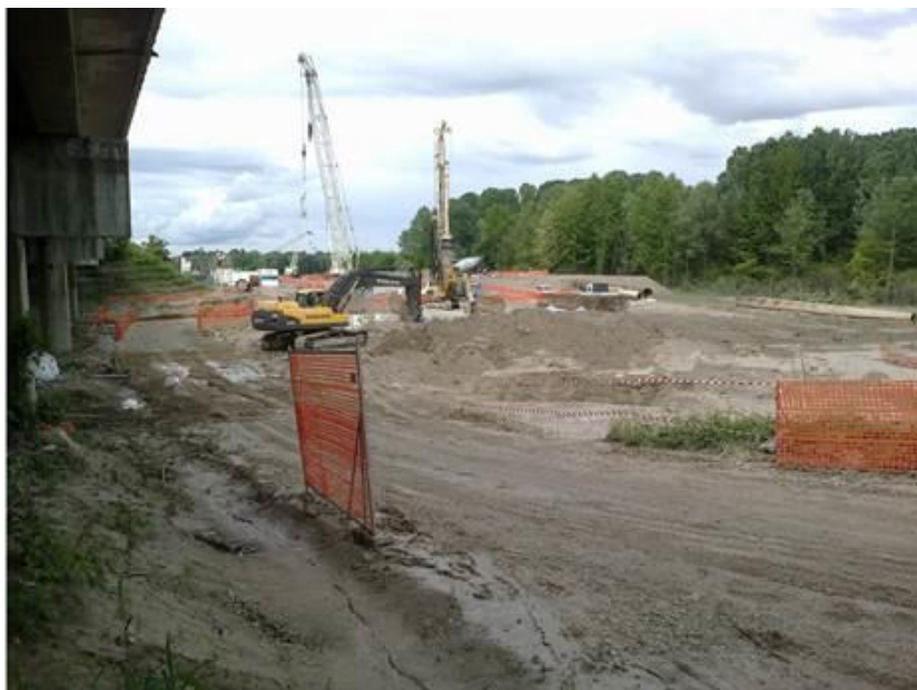
Figura 59 - Un cantiere per la realizzazione della terza corsia dell'autostrada A4 Torino-Trieste (foto di Davide Torassa).
