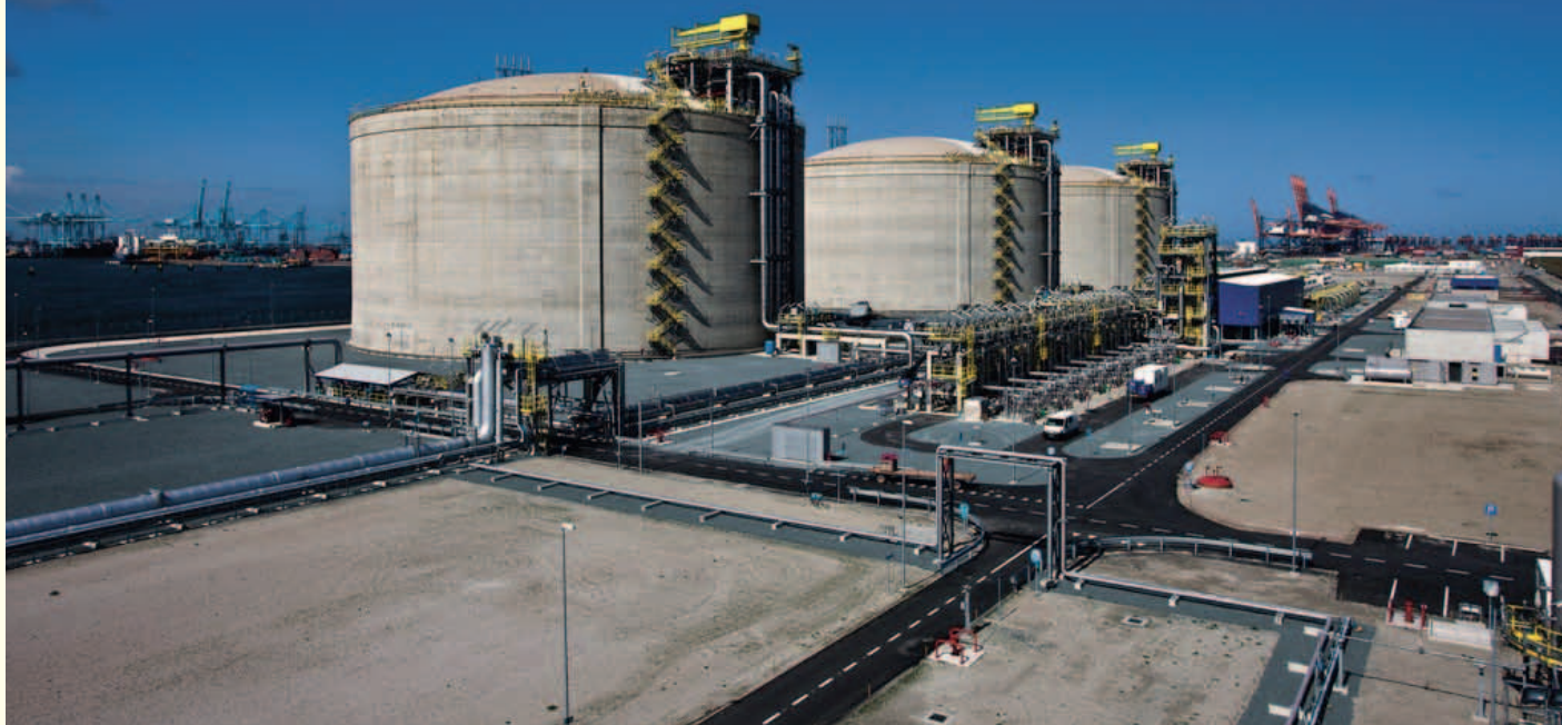
I tre serbatoi di stoccaggio da 180.000 m 3
