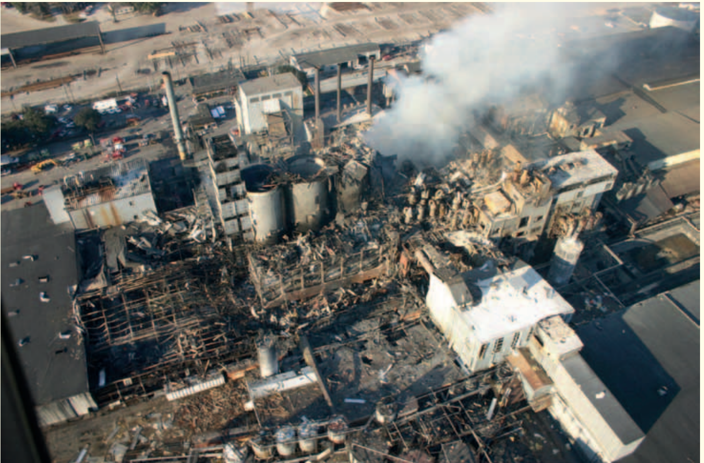
Conseguenze di un'esplosione in un'area a rischio
