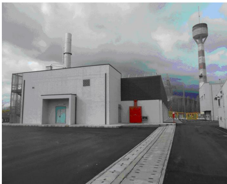
Building storage D1
