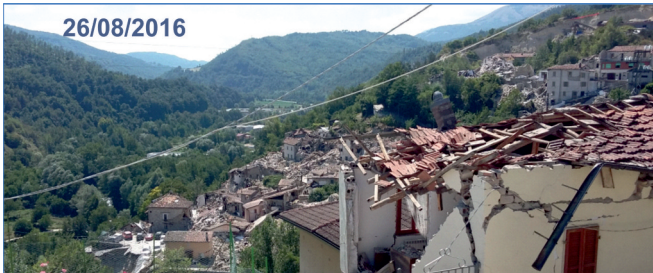
Figura 5.12: Danni subiti dal paese di Pescara del Tronto dopo il terremoto del 24 agosto 2016 e dopo il terremoto del 30 ottobre 2016
