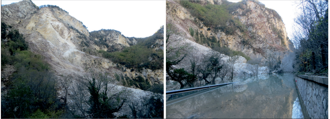
Figura 5.1.4: La frana indotta dal terremoto del 30 ottobre che ha deviato il corso del fiume Nera e che ha interrotto la ex strada provinciale 209 Valnerina, che collega Visso (MC) a Norcia (PG) e Preci (PG)
