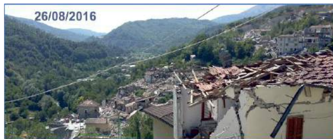
Figura 5.1.2: Danni subiti dal paese di Pescara del Tronto dopo il terremoto del 24 agosto 2016 e dopo il terremoto del 30 ottobre 2016
