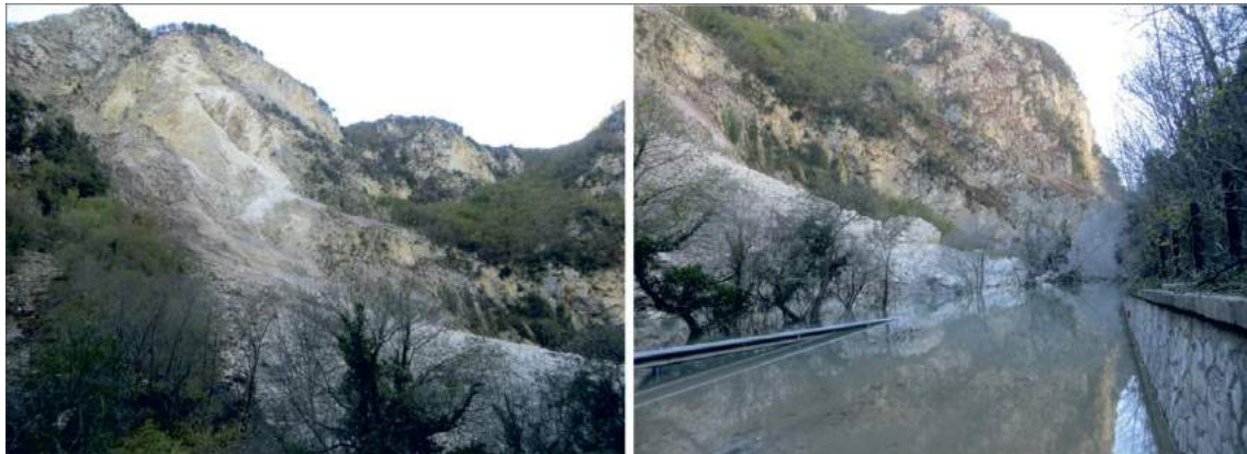
Figura 5.1.4: La frana indotta dal terremoto del 30 ottobre che ha deviato il corso del fiume Nera e che ha interrotto la ex strada provinciale 209 Valnerina, che collega Visso (MC) a Norcia (PG) e Preci (PG)
