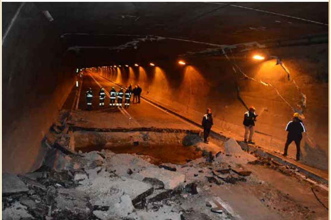
Figura 15.6: Danni prodotti dalla fagliazione superficiale nella galleria tra Capodacqua (in prossimità della Valle del Tronto) e San Pellegrino (nel bacino di Norcia) della strada delle Tre Valli Umbre (SS685)
