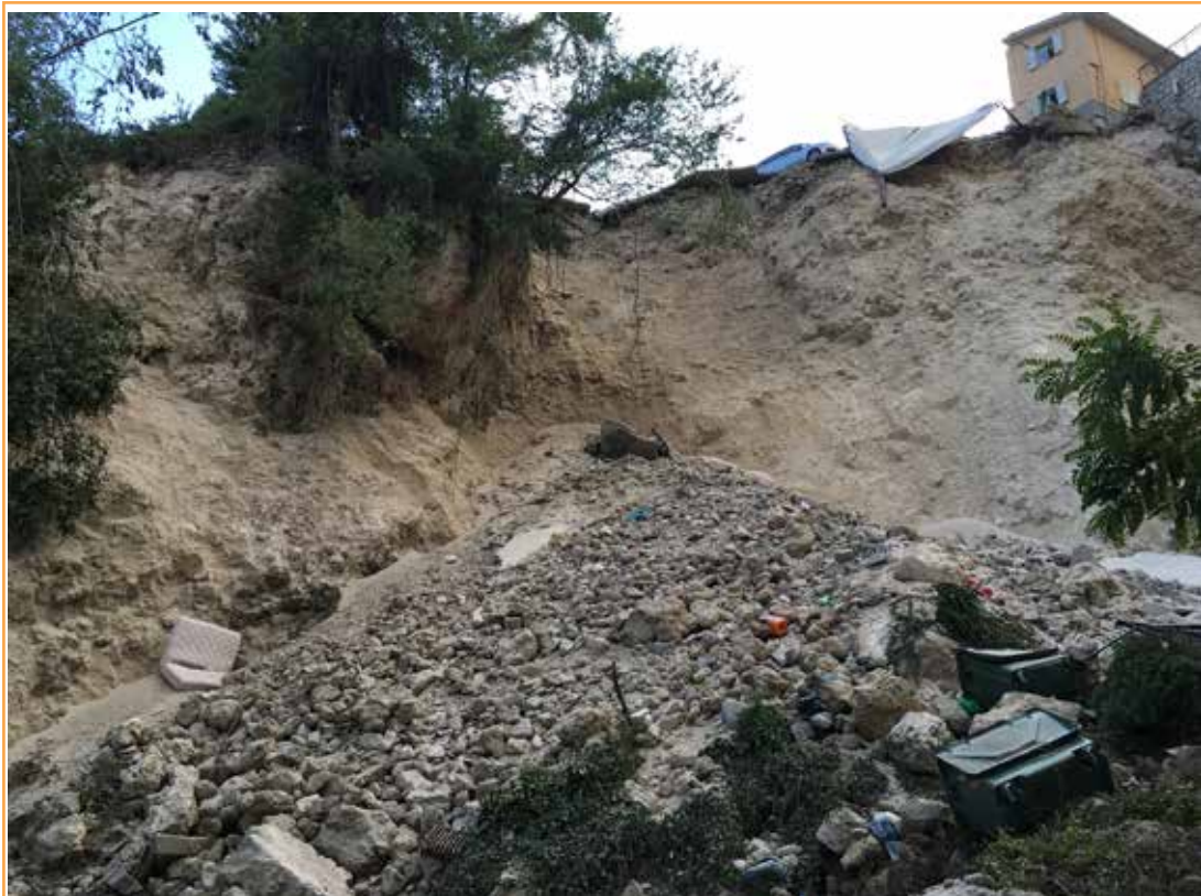
Figura 15.11: Porzione del versante in frana sotto il paese di Pescara del Tronto, visto dalla strada SS 4 Salaria, che è stata ripetutamente interrotta per materiale franato
