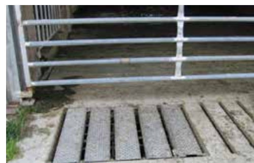
Ricollocazione delle coperture alla fine dell'operazione
