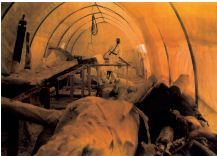
Interno del tunnel di scoibentazione
