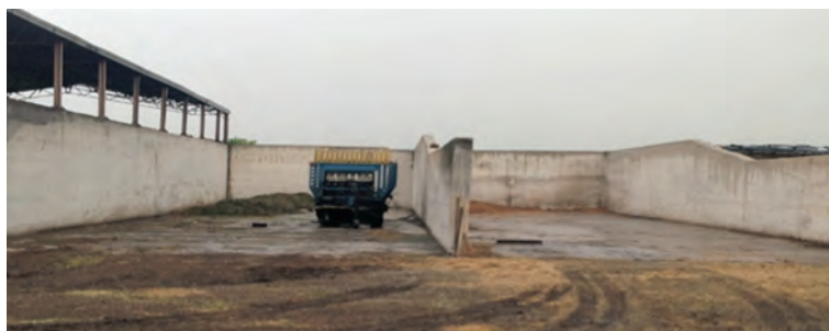
Silo orizzontale. Acerra, azienda Errichiello
