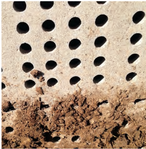
Pavimentazione in cemento di tipo grigliato con scolo dei liquami. Eboli, azienda lemma
