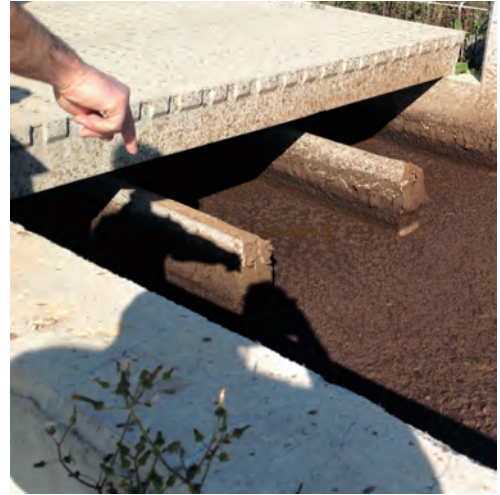
Pavimentazione in cemento di tipo grigliato con scolo dei liquami. Eboli, azienda lemma
