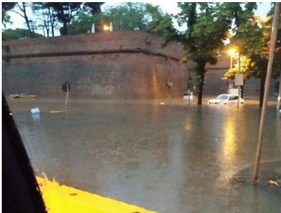
Foto 2.3.1 – Grosseto, 9 giugno 2016. Battente idraulico di ca. 1m nel centro storico, zona tra Porta Corsica e Via Curtatone (fonte: www.meteoweb.eu ).
