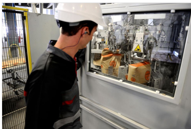
© Gael Kerbaol / INRS Ensachage mécanisé de ciment afin de réduire les émissions de poussières dans une cimenterie
