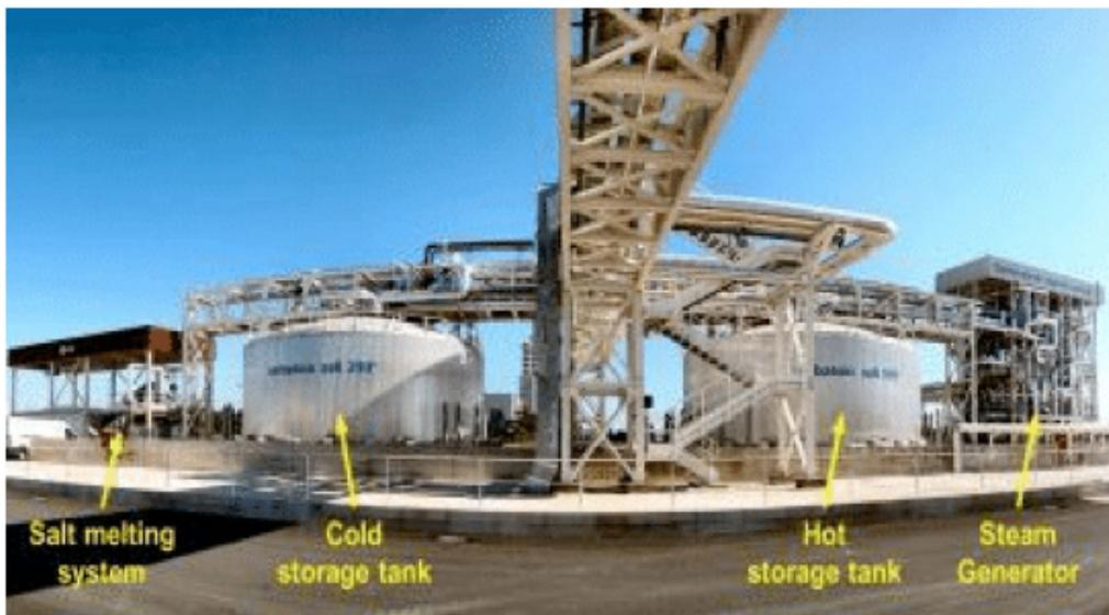
Sistema di accumulo termico da 80MWh a due serbatoi e sali fusi dell'impianto dimostrativo "Archimede" realizzato da ENEL/ENEA a Priolo Gargallo.
