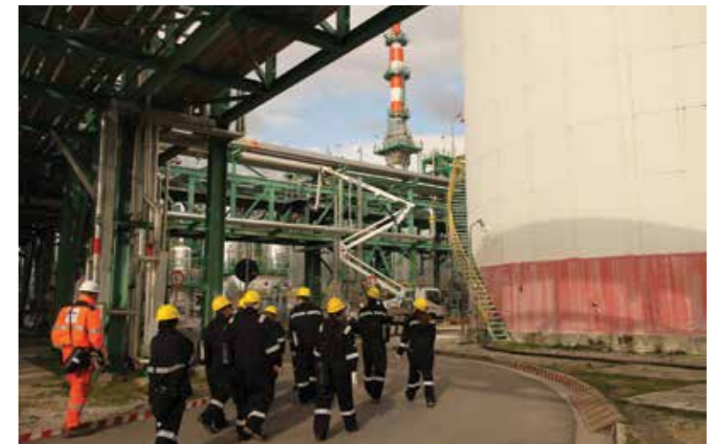
Tecnici in sopralluogo al Centro Olio Val d'Agri di Viggiano (Foto DGS-UNMIG)
