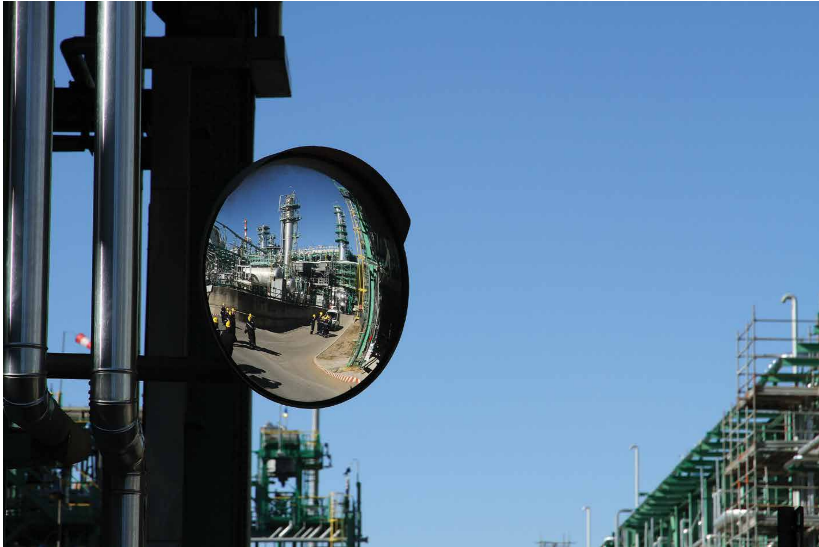
Impianto Val d'Agri, ispezione dei tecnici UNMIG (Foto DGS-UNMIG)
