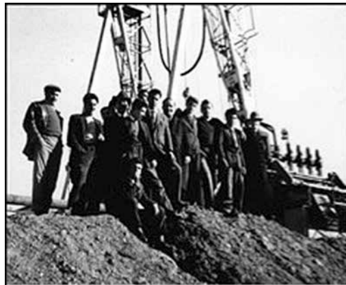
Operai in cantiere negli anni cinquanta (Archivio privato Remo Oriolo, Tramutola)
