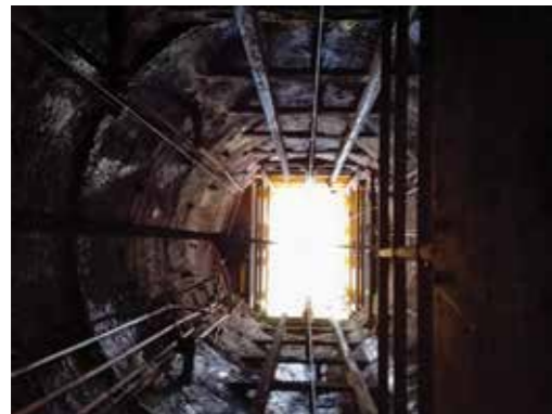
Pozzo di ventilazione di Seruci (Iglesias). Destinato alla chiusura, è in fase di manutenzione per ospitare un modernissimo impianto, primo al mondo, di distillazione criogenica di isotopi rari (Foto Carbosulcis)
