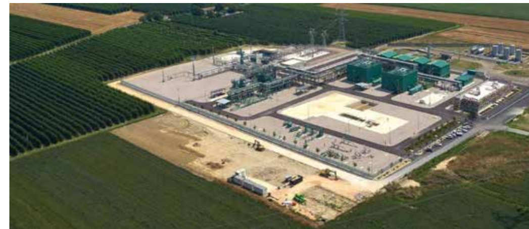
Impianto di stoccaggio di gas naturale, operatore Edison Stoccaggio S.p.A. ( www.edisonstoccaggio.it )
