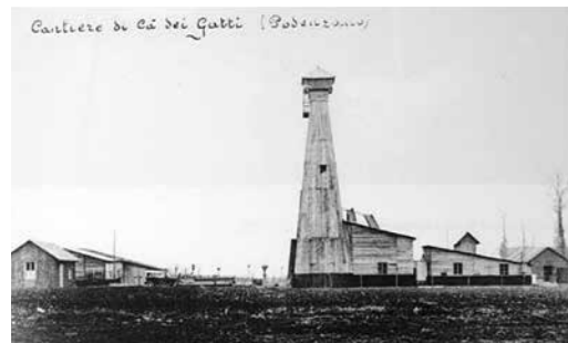
Il cantiere di Ca' dei Gatti a Podenzano
