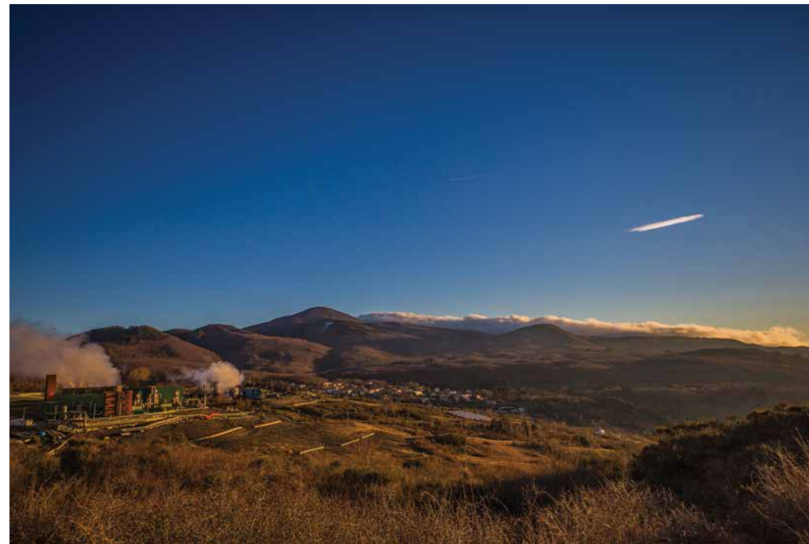
Impianti geotermici a Larderello. In basso a sinistra, la centrale di Bagnore (Archivio fotografico Enel Green Power)
