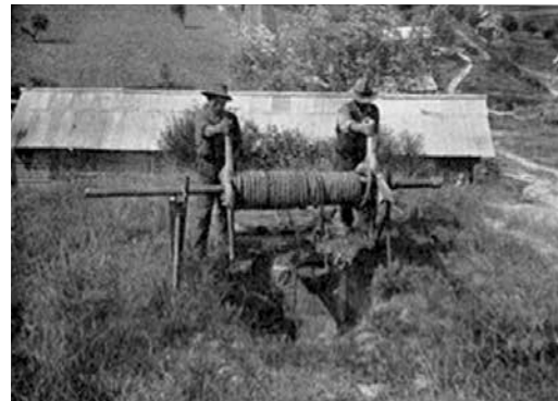
Miniera di petrolio di Vallezza, Fornovo di Taro, Parma. Pozzo scavato a braccia nel 1905 (Da A. Scicli, "L'attività estrattiva e le risorse minerarie dell'Emilia Romagna", Modena, 1972)
