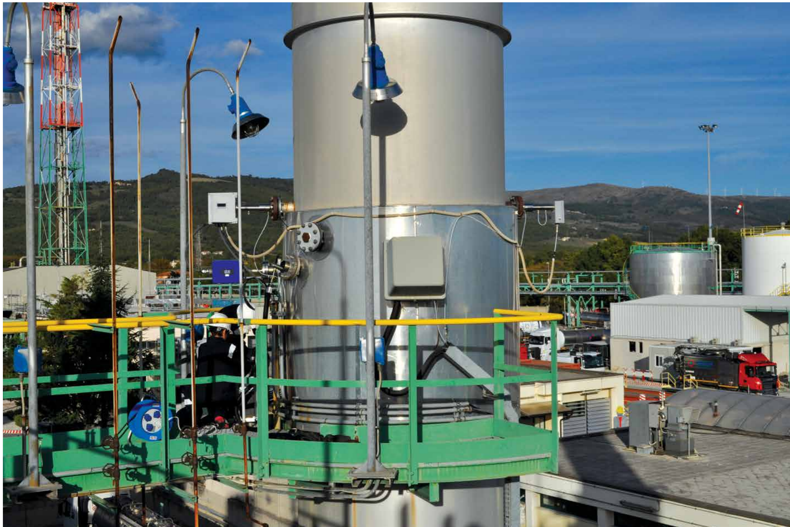
Sopralluogo di tecnici UNMIG sull'impianto Val d'Agri (Foto DGS-UNMIG)
