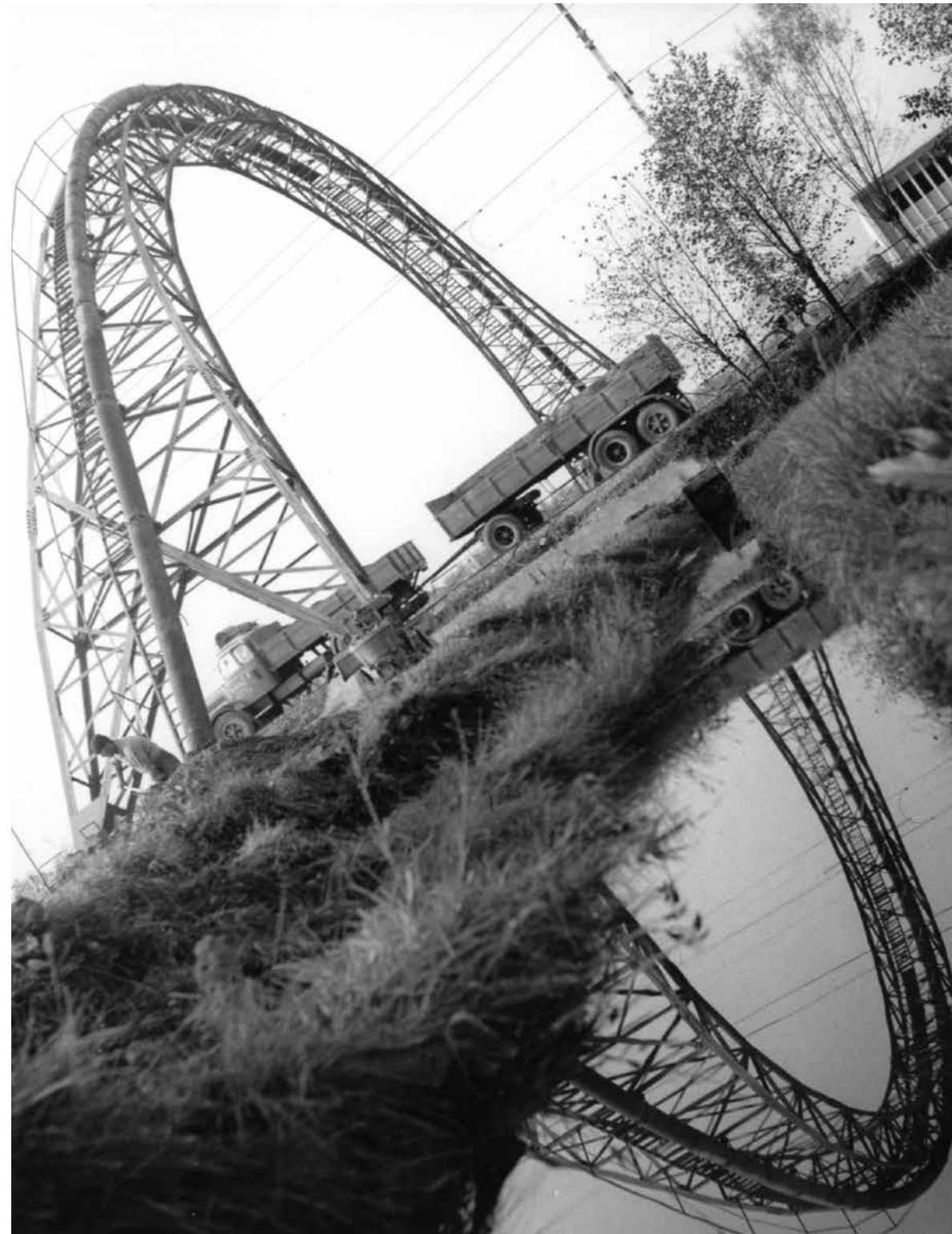
Tratto del metanodotto SNAM a ponte sul Naviglio Pavese (Archivio storico ENI)
