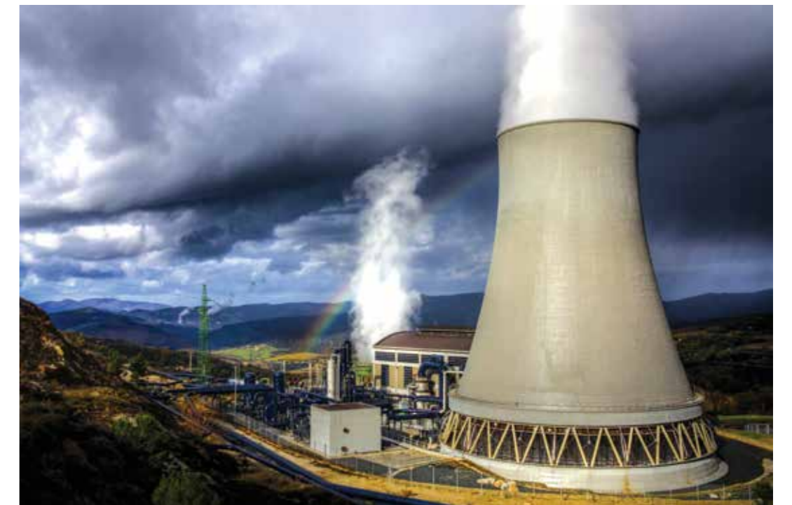
Impianti geotermici nella zona di Larderello, Monte Amiata, in Toscana (Archivio fotografico Enel Green Power)
