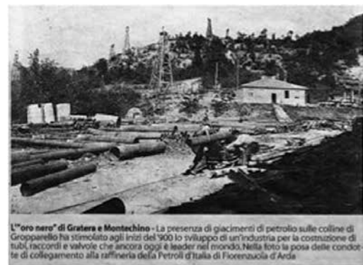
La posa delle condotte di collegamento alla raffineria della Petroli d'Italia di Fiorenzuola d'Arda
