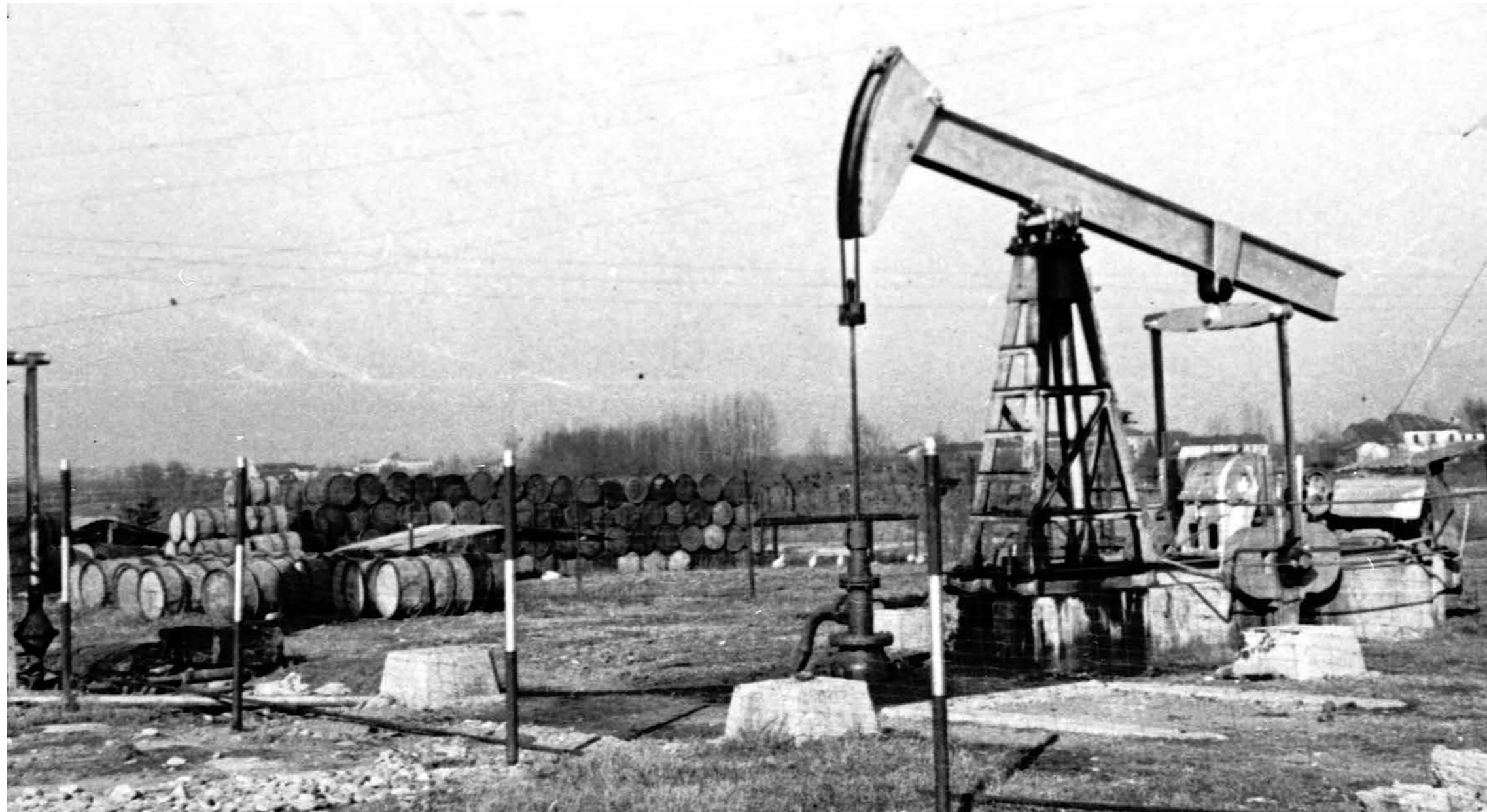
1953 - Cavallo di pompamento nel campo di Fontevivo (Archivio storico ENI)
