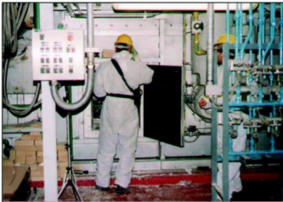
Figure 8: Lavori per la coibentazione di un forno di trattamento termico. È evidente la porta di accesso all'impianto
