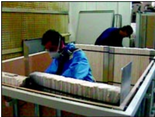
Figura 1: Montaggio del rivestimento in FCR sul tetto di un forno per ceramiche
