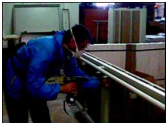
Figure 2 e 3: Lavori di coibentazione con pannelli in FCR di componenti di un forno
