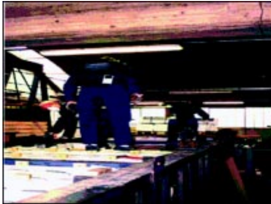
Figura 1: Montaggio del rivestimento in FCR sul tetto di un forno per ceramiche
