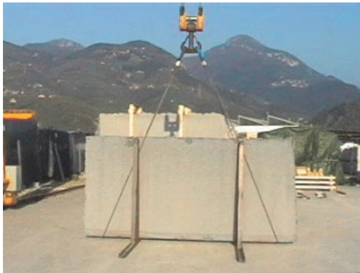
Fig. n. 30: Deposito pastello senza bilancino (Brache a contrasto tra pastello e caprette)
