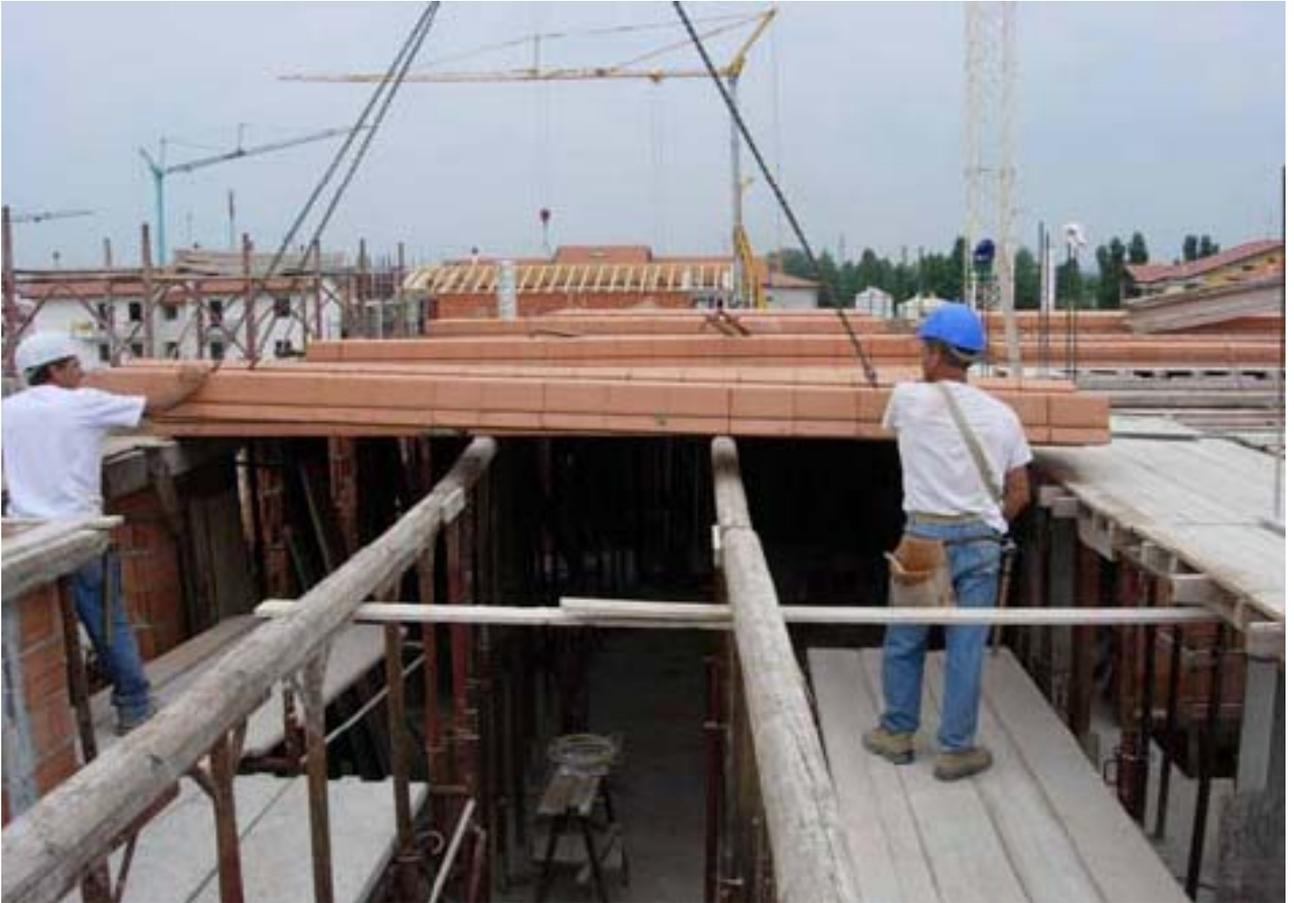
Figura 15. Posa di pannelli utilizzando ponti su cavalletti<sup>42</sup>.
