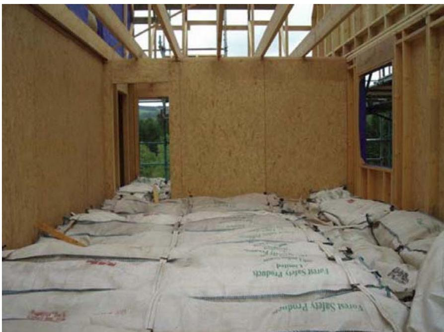
Figura 35. Impiego di materassi di protezione (*soft-filled-mat*).
