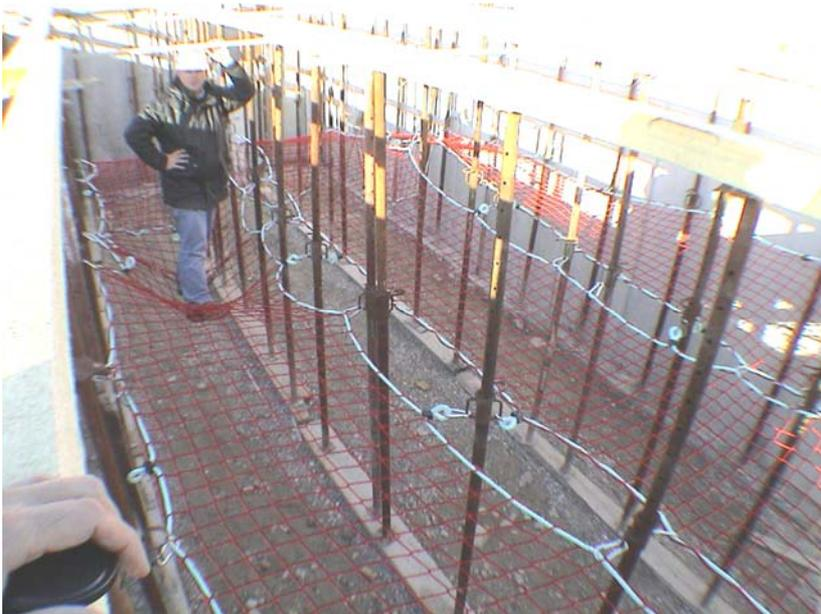
Figura 29. Rete di protezione<sup>63</sup>.
