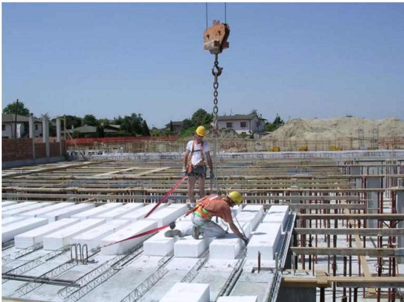
Figura 10. Solaio a pannelli caratterizzati dalla presenza di una superficie di lavoro continua.
