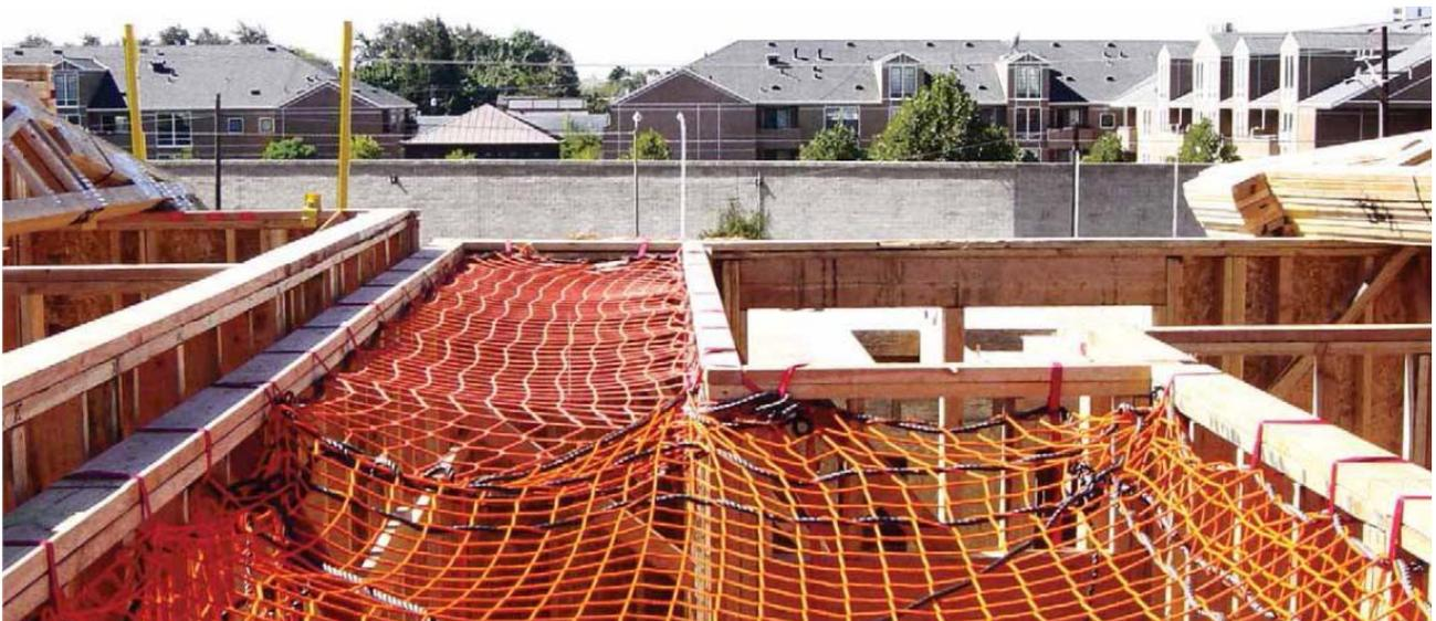
Figura 31. Impiego delle reti di sicurezza<sup>65</sup>
