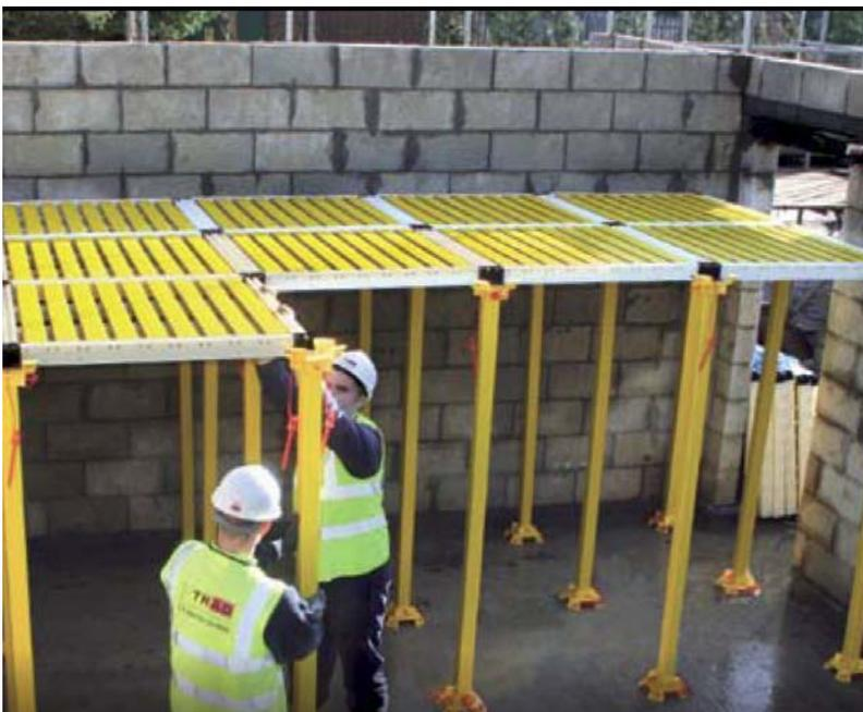
Figura 37. Operazioni di montaggio (TRAD Safety Deck)
