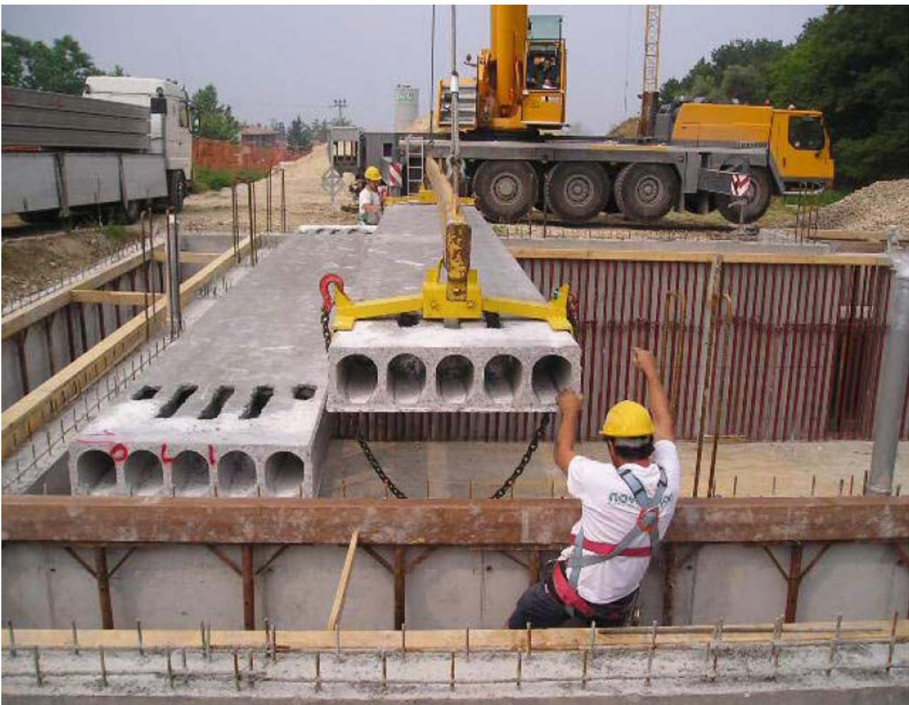
Figura 14. Posa del solaio in presenza di opere provvisionali<sup>41</sup>.
