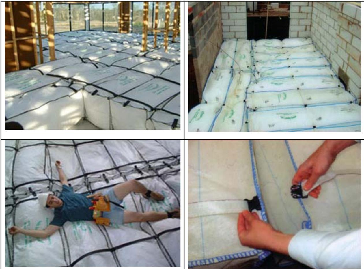
Figura 32. Materassi di protezione.
