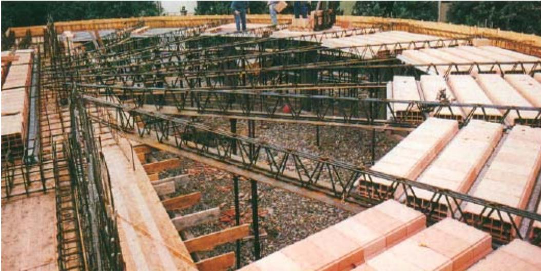
Figura 12. Impiego di solai a travetti in grado di adattarsi alla configurazione planimetrica dell'edificio<sup>39</sup>
