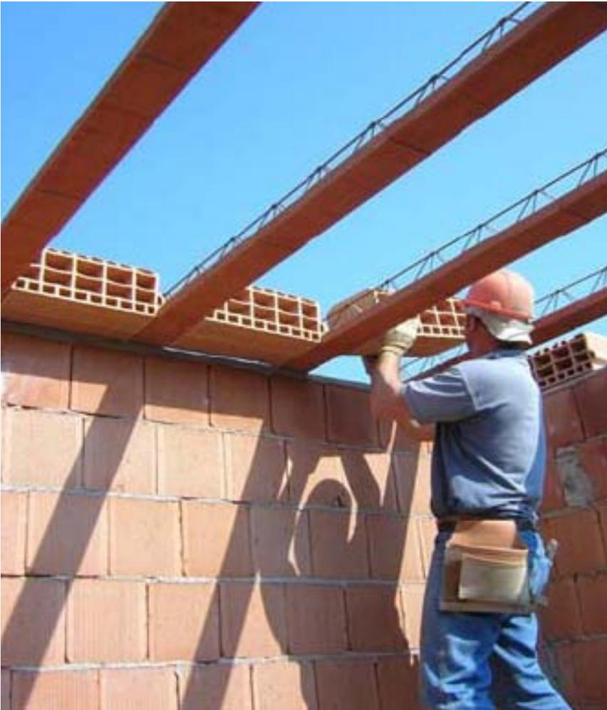
Figura 16. Posa delle pignatte utilizzando un ponte su cavalletti<sup>44</sup>.
