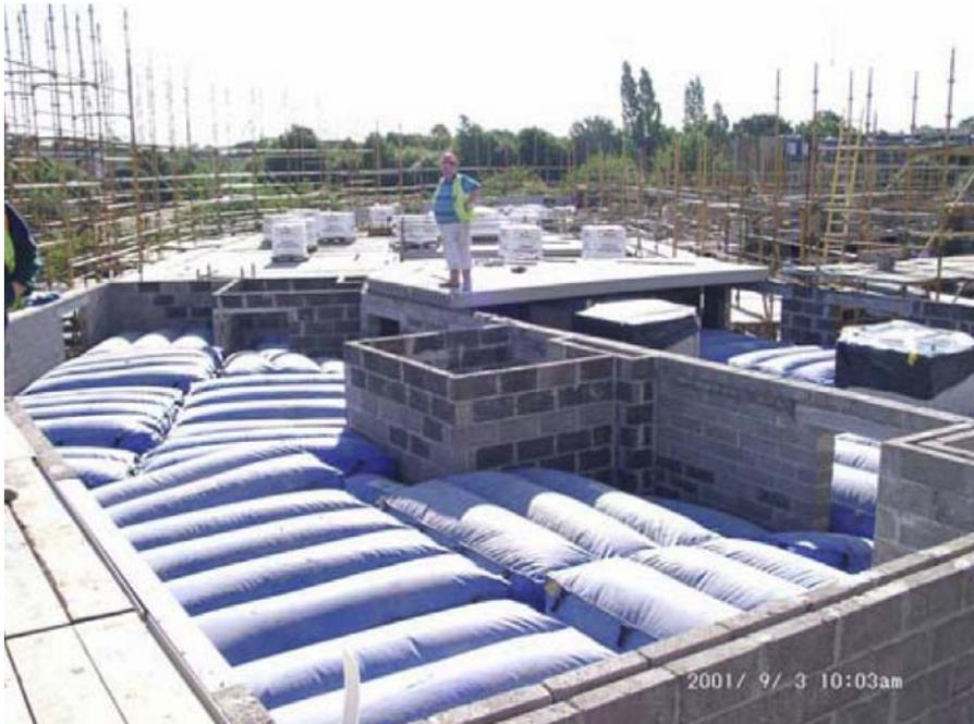
Figura 34. Impiego di materassi di protezione (*air-mat*).
