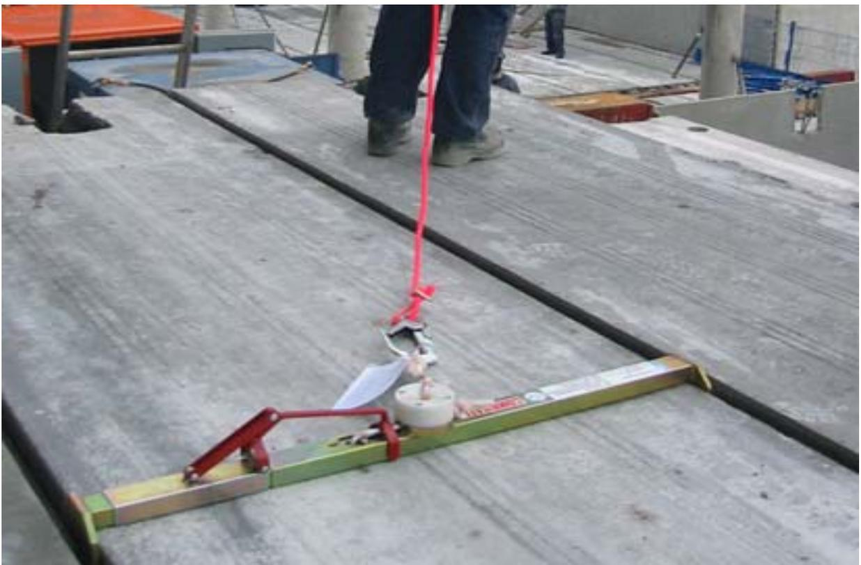
Figura 19. Realizzazione dell'ancoraggio sull'elemento strutturale del solaio<sup>50</sup>
