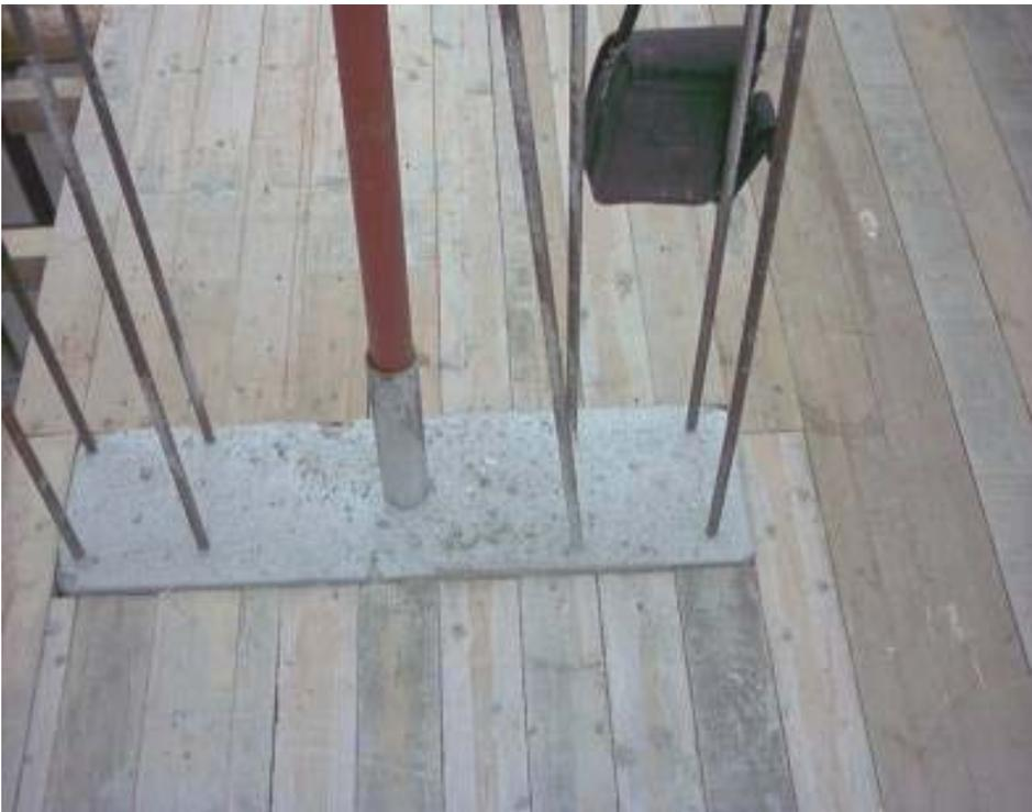
Figura 22. Alloggiamento per il montante di una *lifeline* ricavato sul getto del pilastro<sup>55</sup>.
