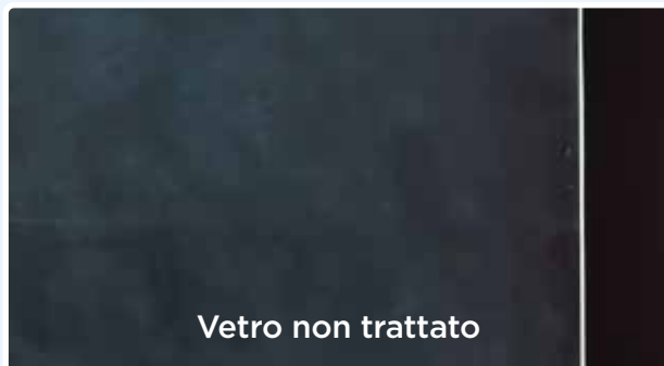
Vetro non trattato: il vetro risulta biancastro. Segno di corrosione del vetro.
