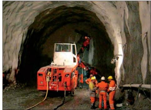
Scavo del fronte: operazioni di perforazione con il jumbo
