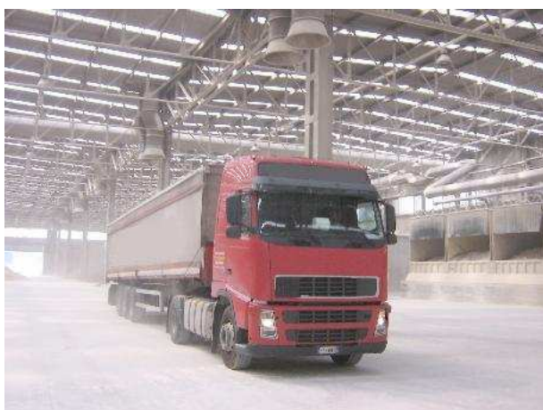
Controllo polveri: diffusione dell'aria (zona centro in alto), e aspirazione (zona laterale in alto).
