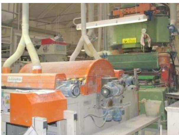
Aspirazione delle polveri dopo pulitura delle piastrelle.
