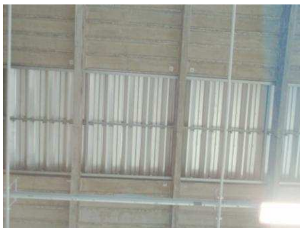
Prese d'aria "a soffitto" (comando a distanza) per ricambio naturale ad alta efficienza.
