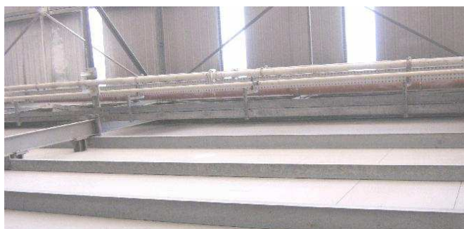
A sx. e al centro: tubazioni per la propulsione delle polveri, rispettivamente tratti verticale e orizzontale.
