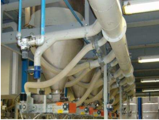
Tubazione con calate per l'aspirazione e raccolta delle polveri aerodisperse all'uscita dei silo.
