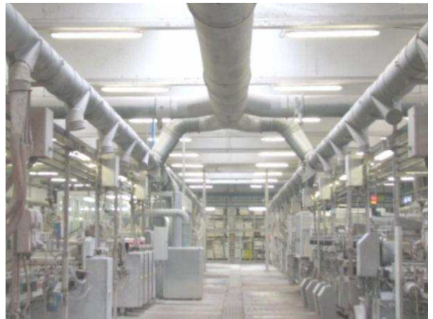
Tubazioni e calate per l'aspirazione delle polveri aerodisperse alle presse e nella smaltatura
