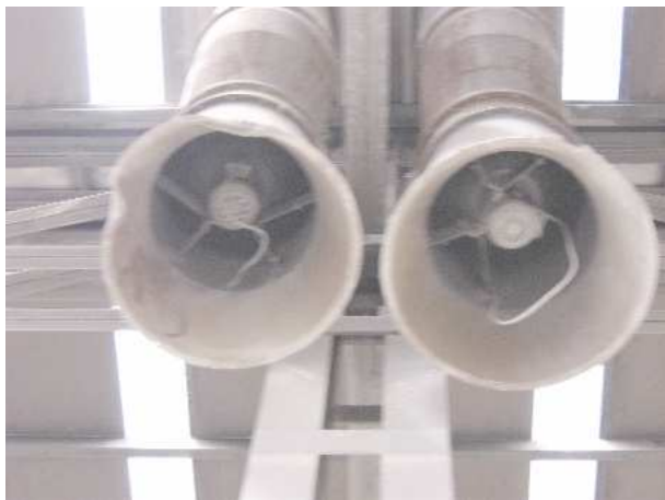
Sistema di controllo dell'aria. Particolari: diffusori e sezione aspirante
