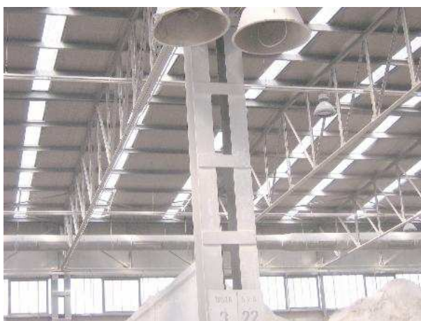
Controllo polveri: diffusione dell'aria (zona centro in alto), e aspirazione (zona laterale in alto).
