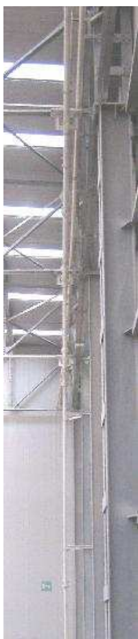
A sx. e al centro: tubazioni per la propulsione delle polveri, rispettivamente tratti verticale e orizzontale.
