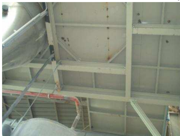
Sigillatura del piano di calpestio della pensilina.
