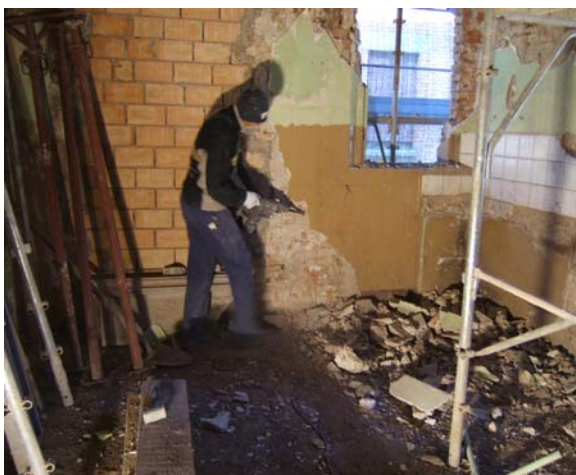
Rimozione rivestimenti e intonaco con attrezzatura meccanica martello percussore
