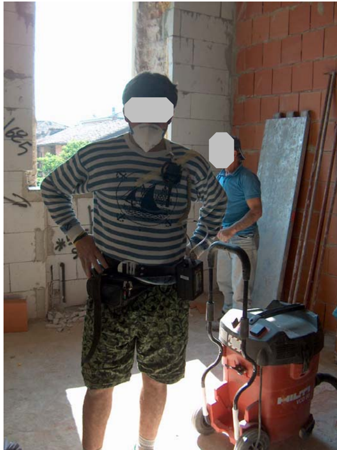
La linea di campionamento SKC Haz Dust IV con ciclone GS3 indossato e l'aspiratore in dotazione alla scanaltrice
