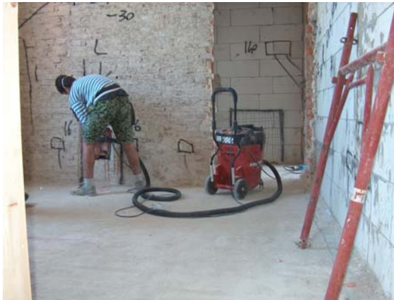
Esecuzione di taglio su mattone pieno con aspirazione allacciata e in funzione
