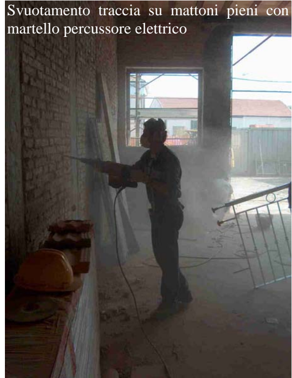
Esecuzione taglio e svuotamento traccia su mattoni pieni
