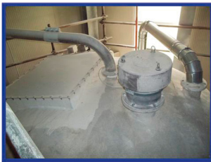
Condizioni della valvola di controllo pressione nelle fasi di carico e di scarico dell'impianto
