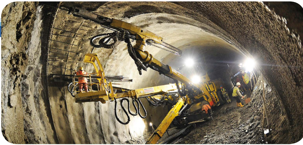
Stabilizzazione della galleria tramite reti di armatura.
