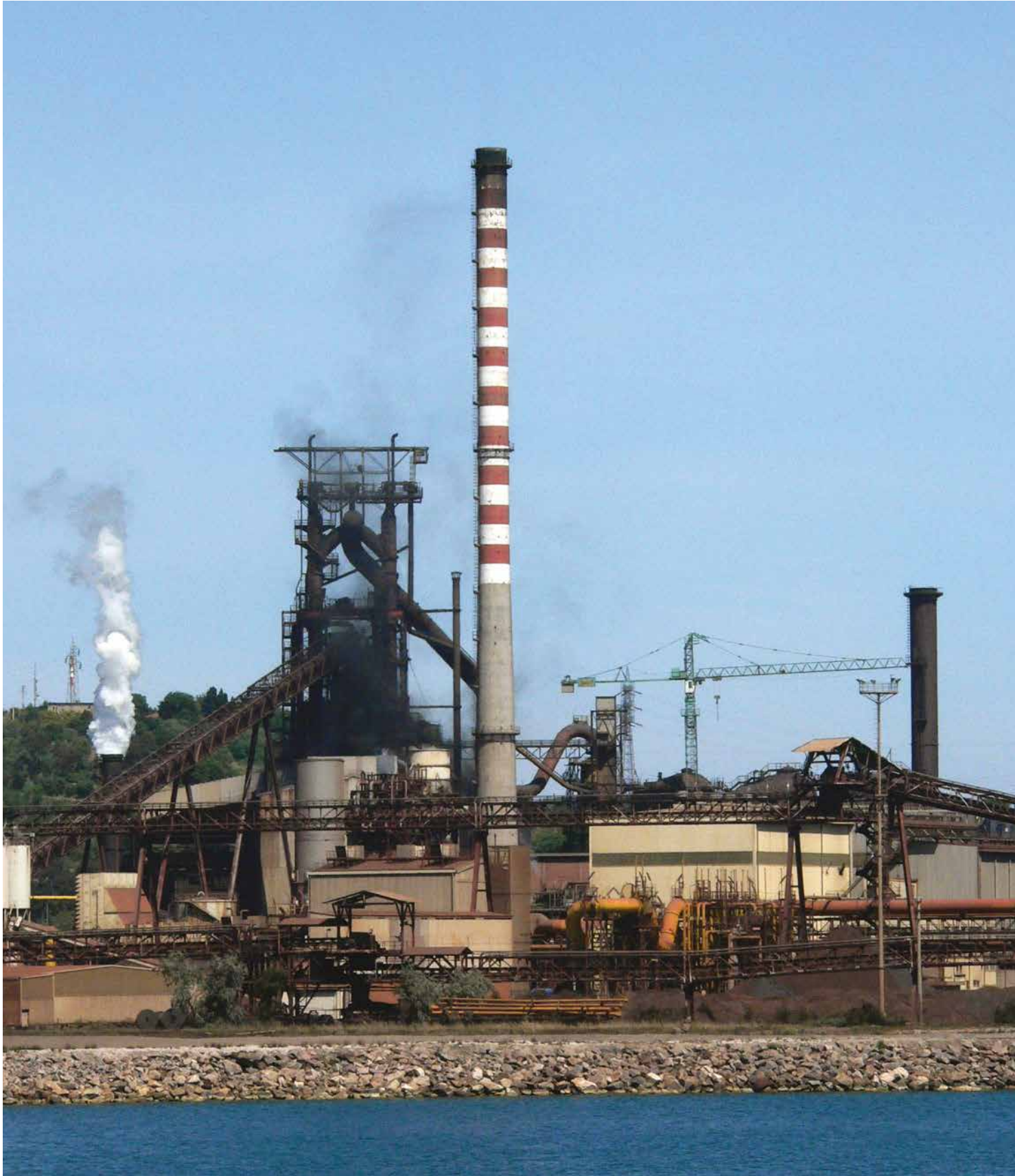
Foto 6.14 Impianti industriali Fonte ISPRA Franco Iozzoli
