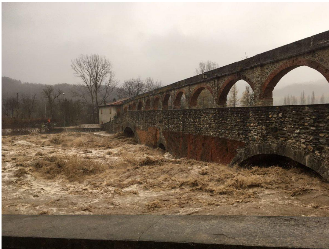
Figura 2.9: Il fiume Tanaro nel corso dell'alluvione di novembre 2016. Fonte: ARPA Piemonte.
