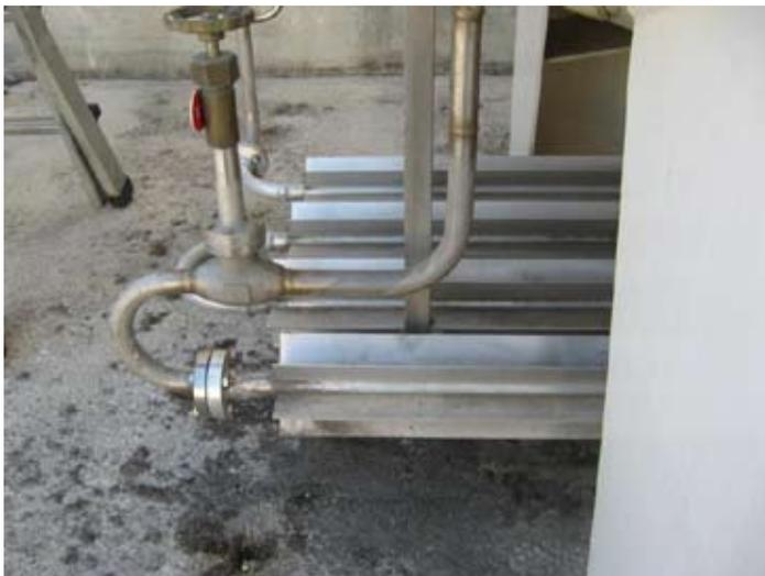
*Figura 6. Inizio di pitting sulle giunzioni saldate impianto rimessa in pressione*
