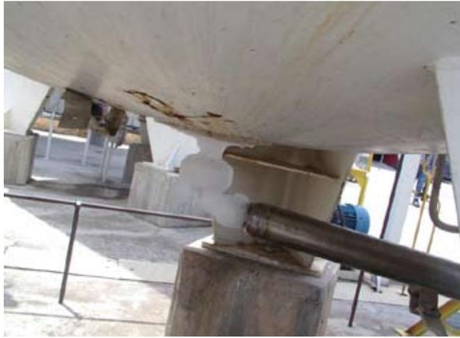
*Figura 3. Scarico liquido freddo per la messa in pressione. E' il punto dove solitamente si concentrano i percolamenti delle piogge*
