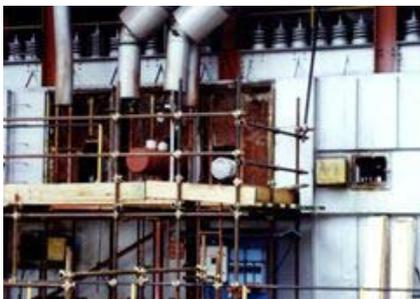
Figura 6 - Montaggio collettori AT: vista dall'esterno del generatore
