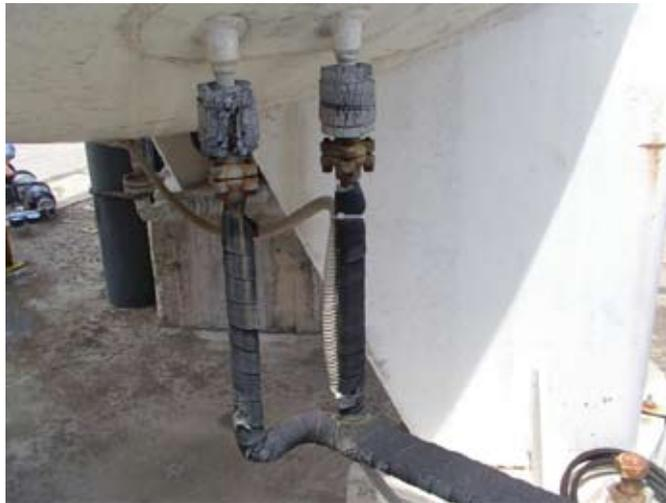
*Figura 4. Connessioni per il vuoto con bulloni ossidati e guarnizioni degradate*
