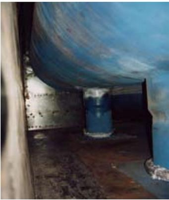
Figura 12 - Vista esterna corpo cilindrico: saldature di attacco bocchelli di attacco bocchelli tubi di caduta
