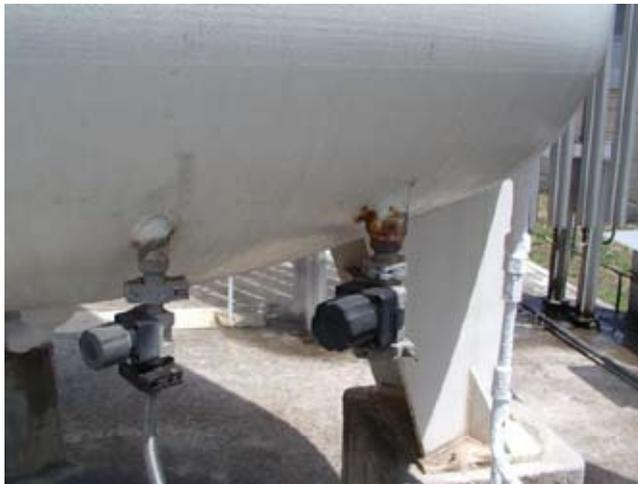
*Figura 2. Valvola del vuoto ossidata a ridosso della connessione. Si nota accanto la valvola per la misurazione del vuoto al fine di riscontrare eventuali problematiche di tenuta*
