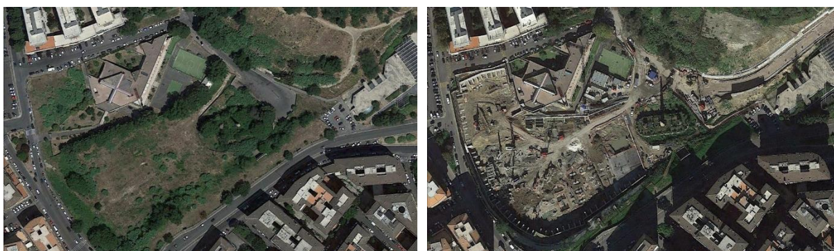
Figura 7 - Cantiere per la costruzione di un nuovo polo commerciale a Valle Aurelia (zona centrale di Roma). A sinistra l'area nel 2015, a destra la stessa area nel 2016.
