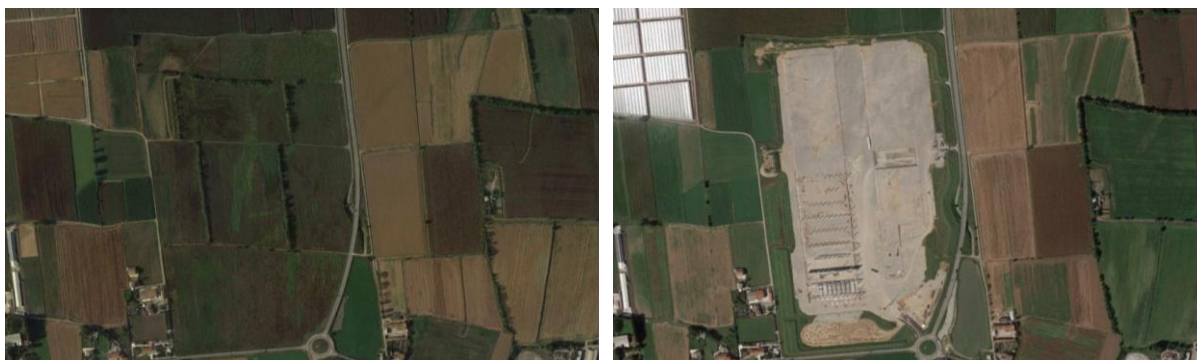
Figura 6 - Cantiere per la costruzione di un nuovo polo logistico a Calcio (Bergamo). A sinistra l'area nel 2015, a destra la stessa area nel 2016.
