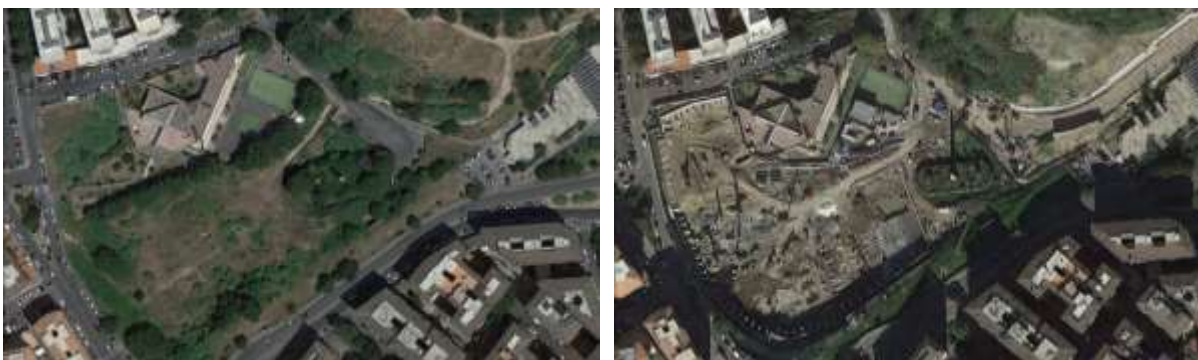
Figura 9 - Cantiere per la costruzione di un nuovo polo commerciale a Valle Aurelia (zona centrale di Roma). A sinistra l'area nel 2015, a destra la stessa area nel 2016.
