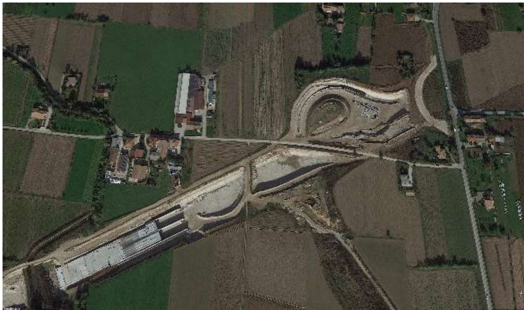
Figura 2 - Cantiere per la costruzione di una nuova infrastruttura a Riese Pio X (Treviso). In alto l'area nel 2015, in basso la stessa area nel 2016.
