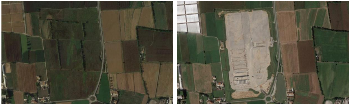
Figura 8 - Cantiere per la costruzione di un nuovo polo logistico a Calcio (Bergamo). A sinistra l'area nel 2015, a destra la stessa area nel 2016.
