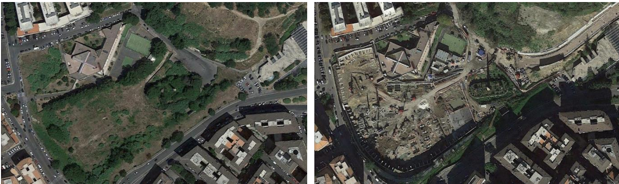
Figura 9 - Cantiere per la costruzione di un nuovo polo commerciale a Valle Aurelia (zona centrale di Roma). A sinistra l'area nel 2015, a destra la stessa area nel 2016.
