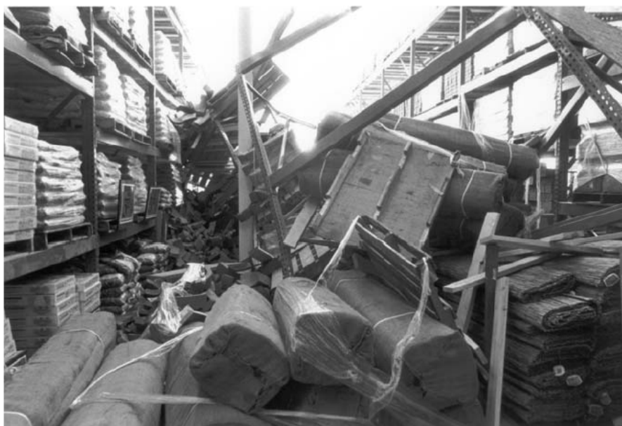
Terremoto di Northridge (1994): Collasso scaffalatura metallica a Santa Clarita (FEMA 460)
