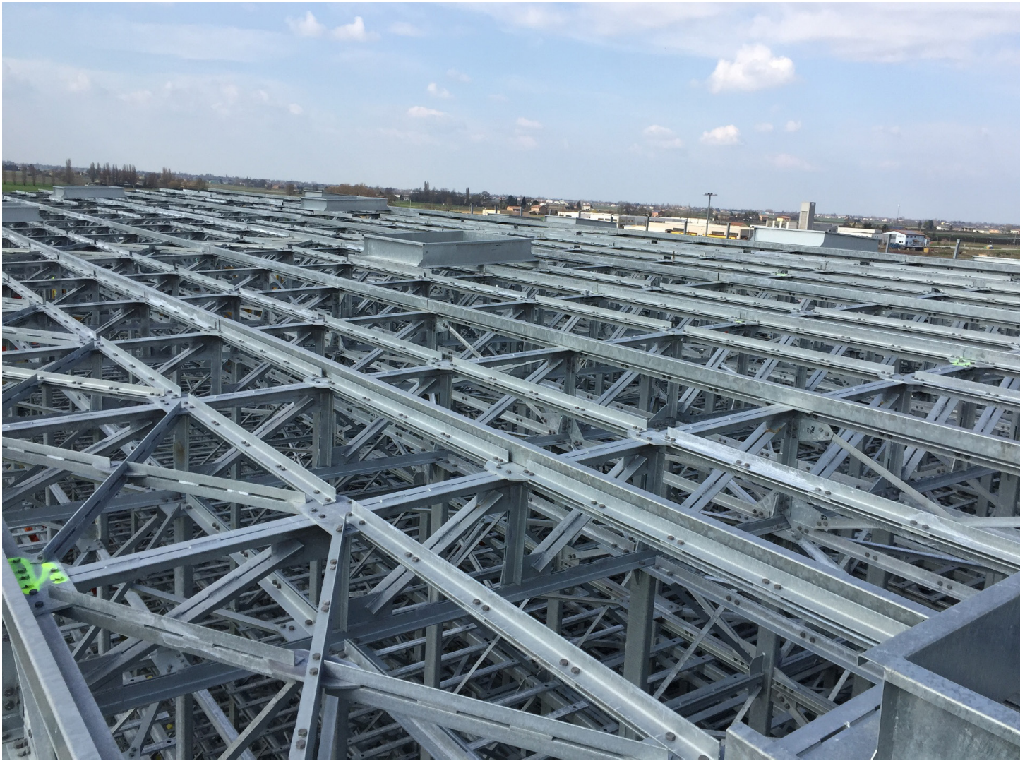
Vista delle capriate in acciaio di copertura e degli evacuatori di fumo prima della posa dei pannelli sandwich
