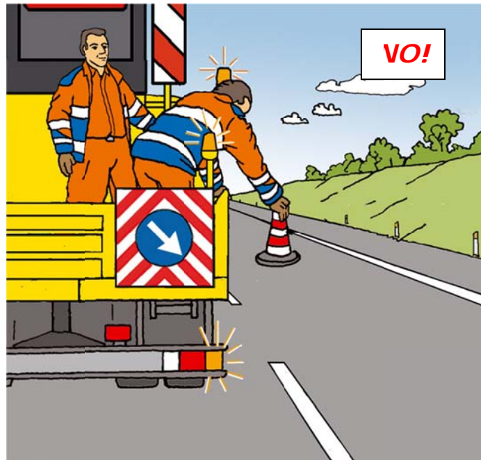
Figura 60 – Posizionamento dei coni o defleco: comportamento scorretto
