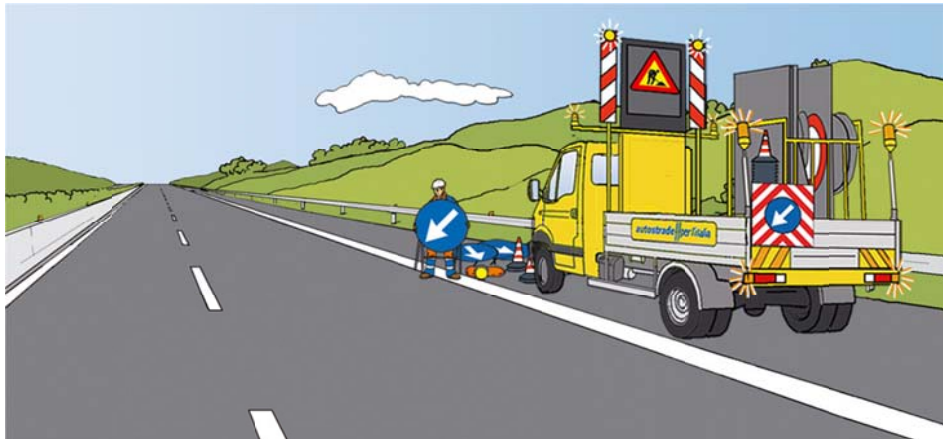
Figura 31 – Chiusura della corsia di marcia: scarico ed inizio installazione della segnaletica di esclusione della corsia
