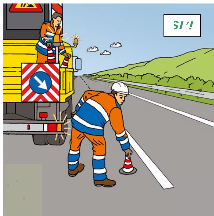
Figura 59 – Posizionamento dei coni o defleco: comportamento corretto
