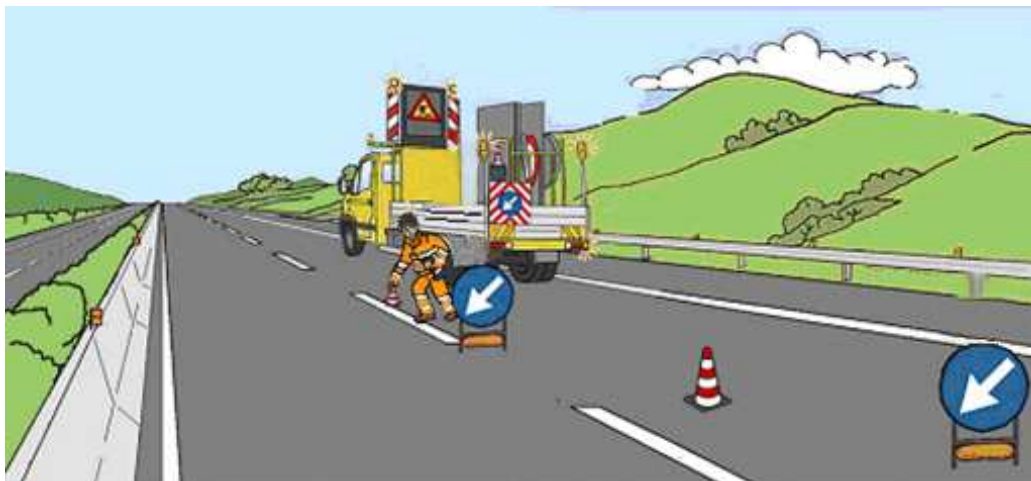
Figura 26 – Chiusura della corsia di marcia: inizio della posa dei coni
