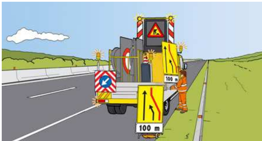
Figura 23 – Chiusura della corsia di marcia: scarico ed installazione sul margine destro dei segnali di riduzione ad una corsia
