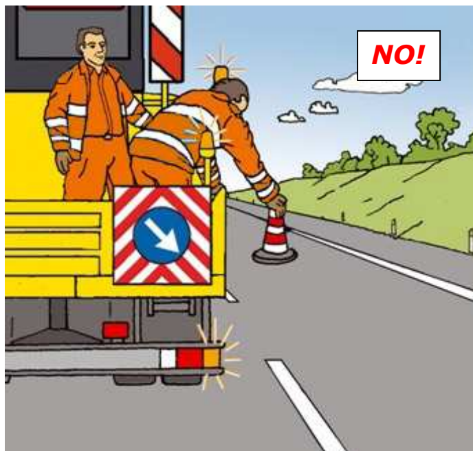
Figura 36 – Posizionamento dei cono o delineatori flessibili: comportamento scorretto
