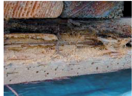
Abbildung 6.13: Holzmehl von holzschädigenden Insekten
