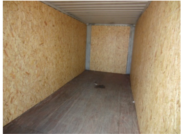
Abbildung 7.53: Auskleidung eines 40'-Containers mit Spanplatten
