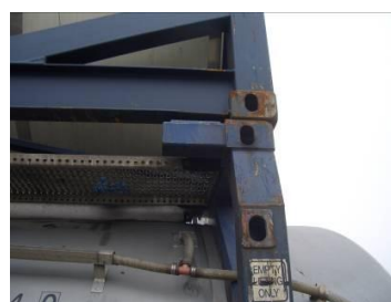
图 4.9 第二册提升孔处的内缩
