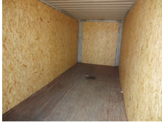
الشكل 53.7 - تبطين حاوية 40 قدم بألواح من الكرتون الخفيف
