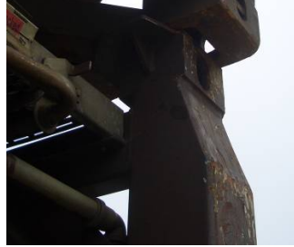
الشكل 8.4 - انخفاض عند إحدى التثبيتات العلوية
