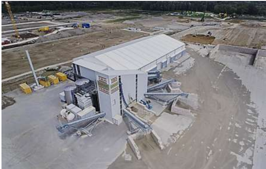
Figura 2.3- Veduta aerea di un impianto di SW (davanti), impianto di trattamento del fango (lato sinistro) e area di ricevimento (dietro). Copyright: ARGE AUDI IN-Campus GbR (Dr. Benjamin Faigle – Züblin Umwelttechnik GmbH)
