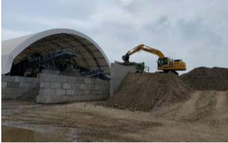
Figura 1.2 - Area di carico del terreno contaminato
