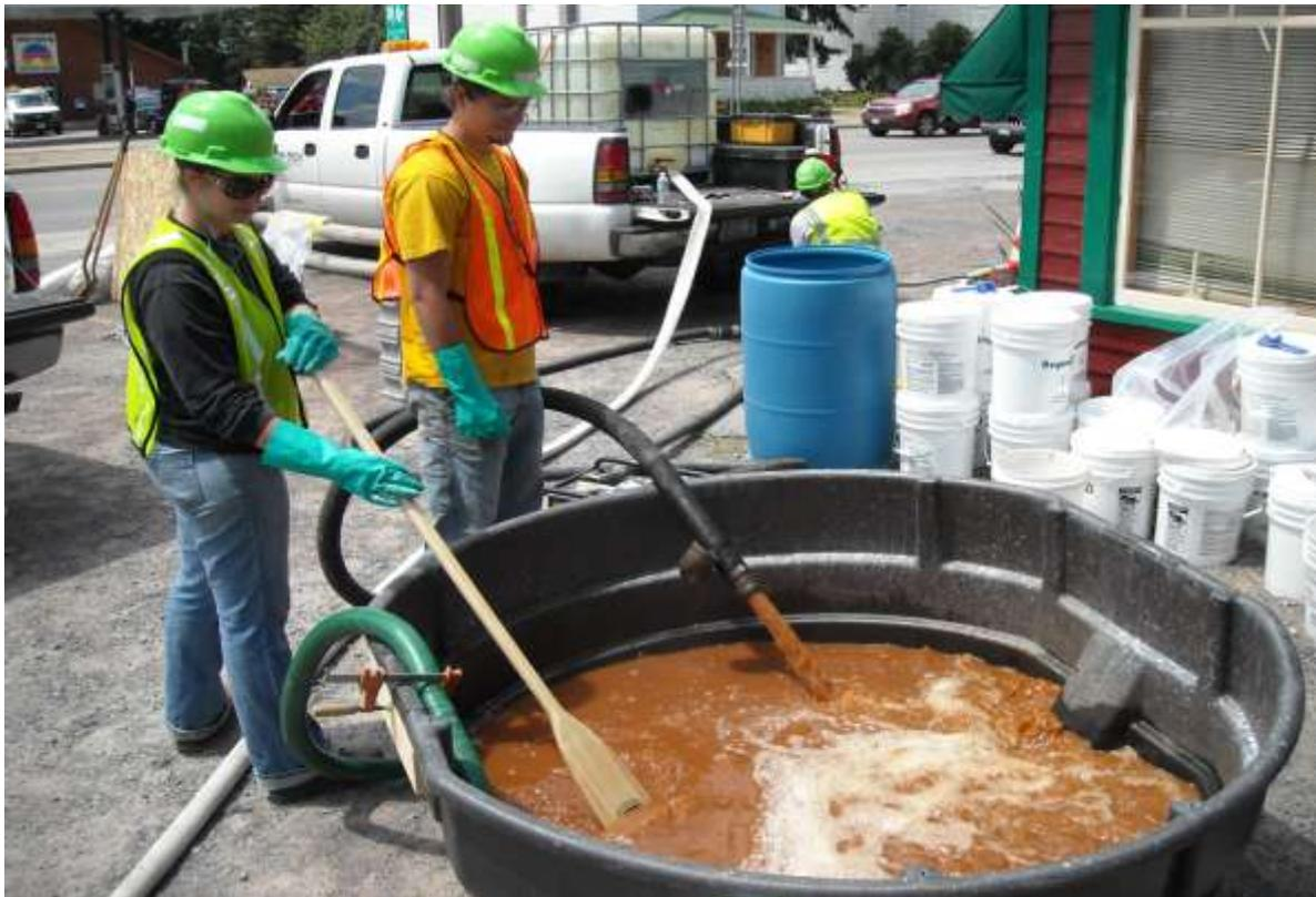
Figura 2.5- Preparazione della soluzione da iniettare
