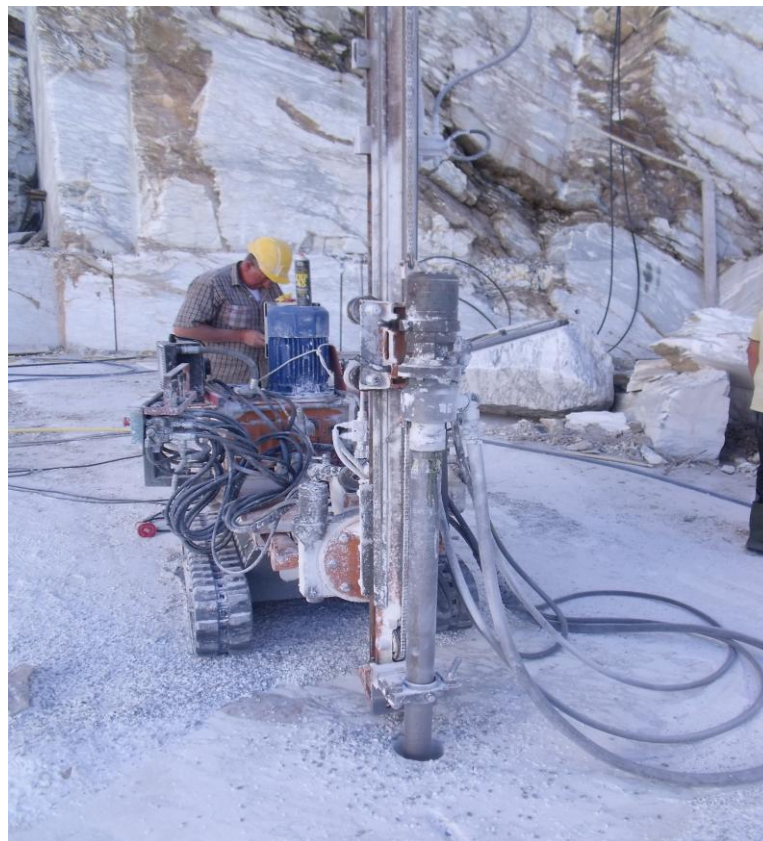
Foto IV.1.5 – Perforatrice a rotazione su affusto cingolato
