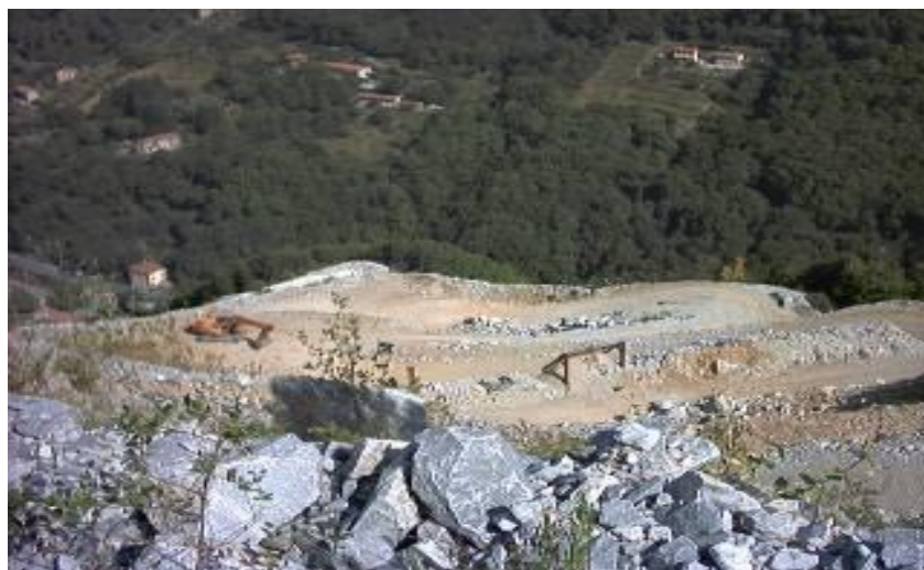
Foto IV.1.2 – Rampe di arroccamento in cava
