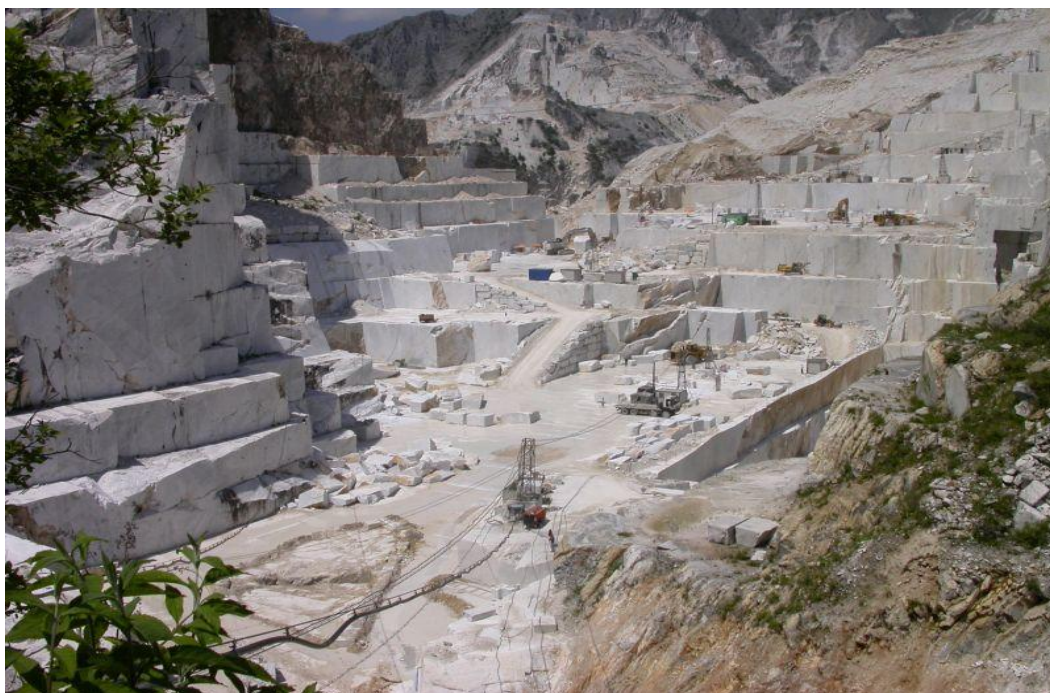
Foto V.2.3 – Vista dall'alto della distribuzione elettrica
