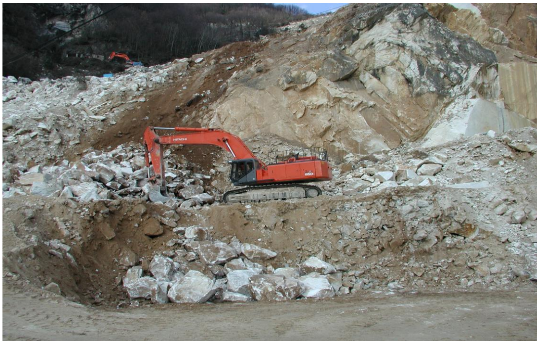
Foto II.3.1 - Escavatore in cave di marmo
