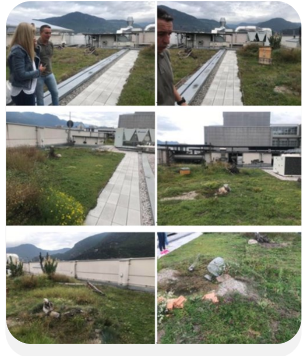
Figura 5.3 - Tetto verde della Fiera di Bolzano, particolari costruttivi e funzionali alla biodiversità
