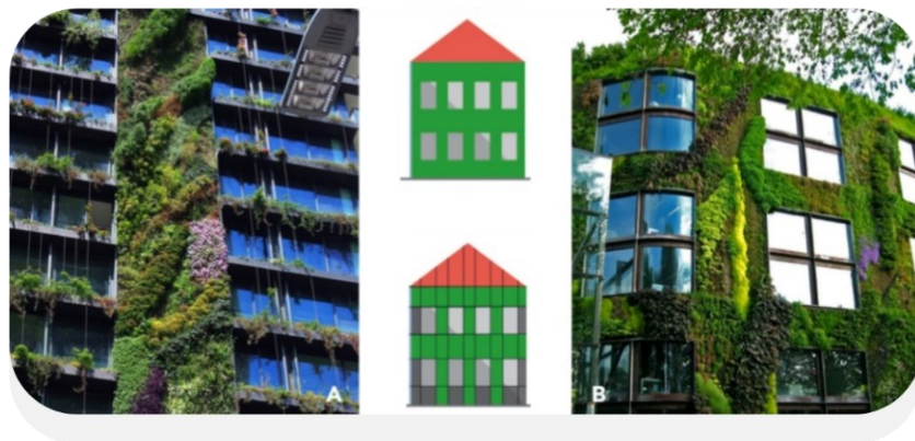
Figura 3.11 - A) One Central Park Tower, Sydney. Il più alto muro vegetale del mondo realizzato nel 2013. B) Museo del Quai Branly, Parigi. Realizzato nel 2004, 800 m 2 e 15.000 piante di 150 tipi diversi. Nel 2017 è stato arricchito con 350 specie differenti provenienti da tutto il mondo. (Fonte: https://www.murvegetalpatrickblanc.com )
