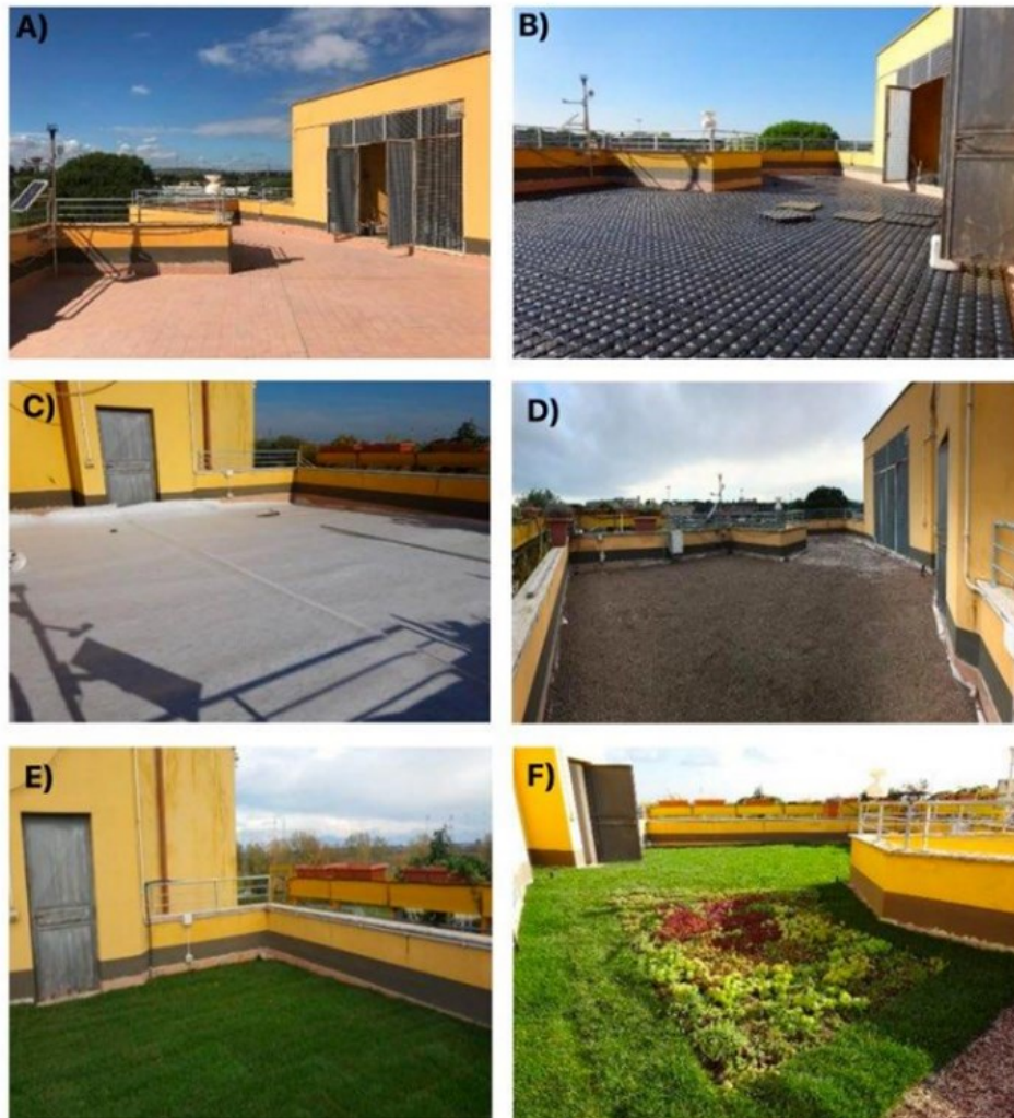
Figura 5.18 - Fasi di installazione del tetto verde ENEA presso il C.R. Casaccia, Roma. A) Lastrico solare prima dell'installazione; B) collocazione del "drain roof"; C) collocazione del geotessuto; D) substrato "vulcan floor"; E) copertura di un settore con prato a Graminacee; F) copertura di un settore con mix di specie di Sedum
