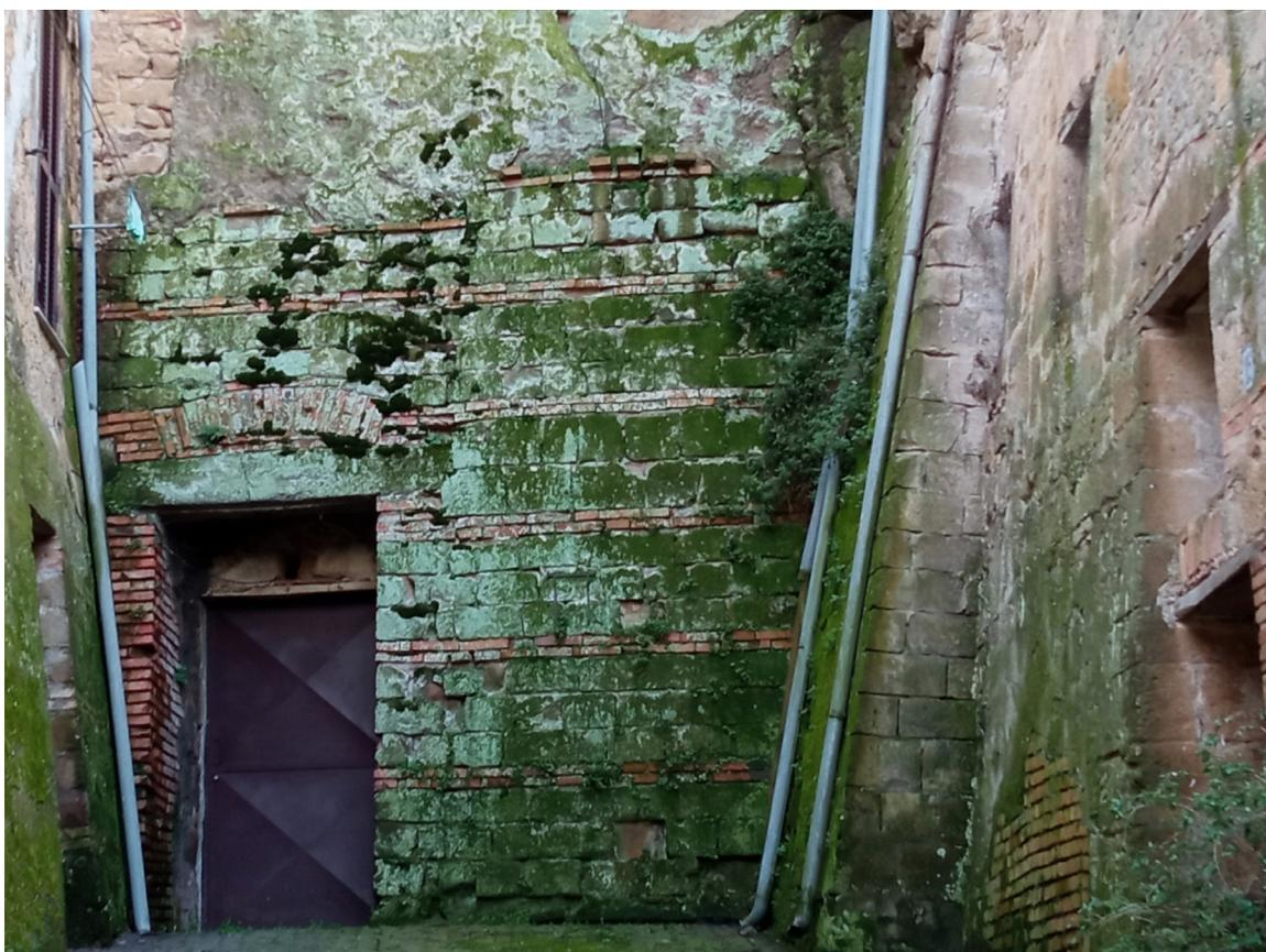
**Fig. 16:** Crescita di patine biologiche in un muro della parte del borgo esposta a nord.
