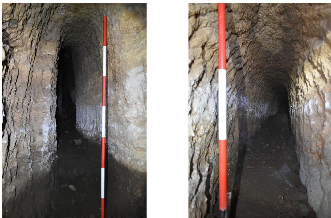
**Fig. 6, 7:** Inquadramento tipologico C. Bizzarri del tratto principale: volta ogivale 1A, e tratti secondari laterali: volta a tutto sesto 1B.
