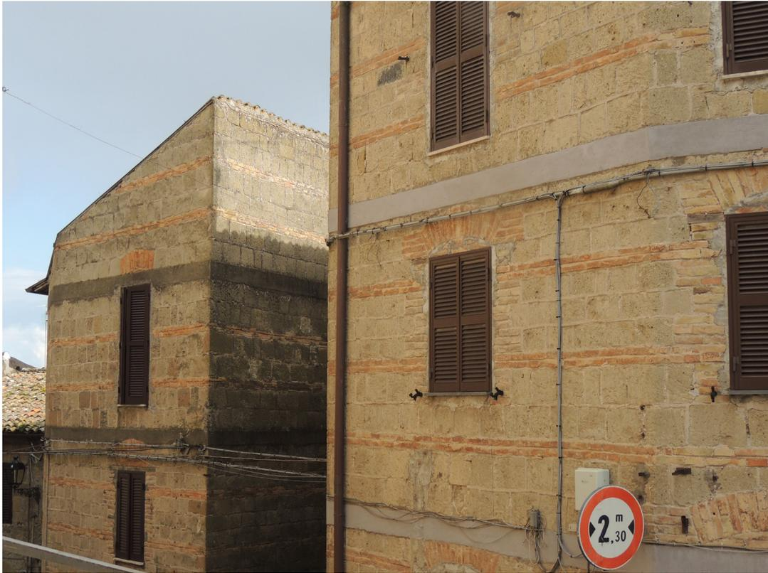
**Fig. 8:** Edifici ricostruiti dopo il terremoto del 1922. Si notano i solai in cemento armato e la muratura in cui ogni tre corsi in conci di tufo squadrati si alternano due corsi di laterizio.
