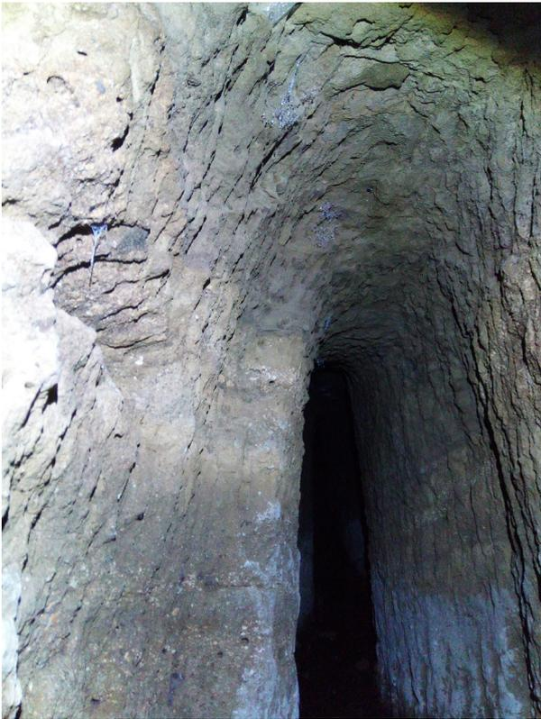
**Fig. 9:** Restringimento del condotto e correzione del grado di orientamento.
