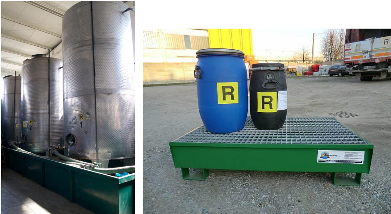
Fig. 10 - Esempi di bacini di contenimento
