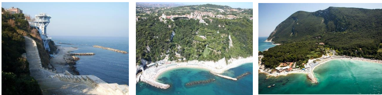
Fig 9.1, 9.2, 9.3 - Esempi di litorale protetto da opere costiere dove sono stati effettuati i campionamenti (sin - Passetto ascensore centro - Spiaggia Urbani di Sirolo e destra - Portonovo molo)
