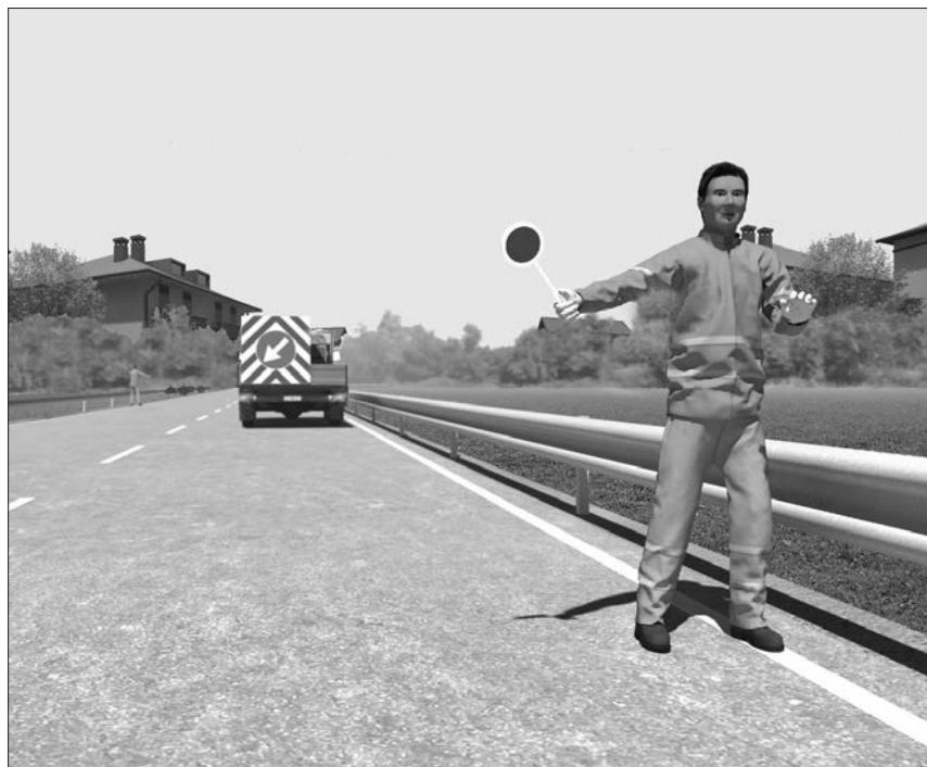
Figura 6 - Fase n. 7 per la posa segnaletica temporanea: l'operaio 1 e l'operaio 2 bloccano con la paletta la circolazione dei veicoli su entrambe le corsie.
