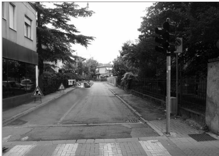
Figura 3 - Manutenzione rete fognaria, vista "a monte" delle aree oggetto dell'intervento.
