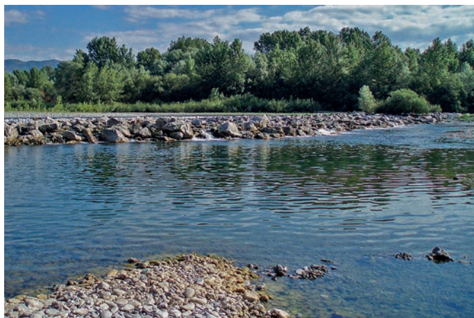
Sbarramento sul Fiume Magra (Foto L. Ciuffardi)
