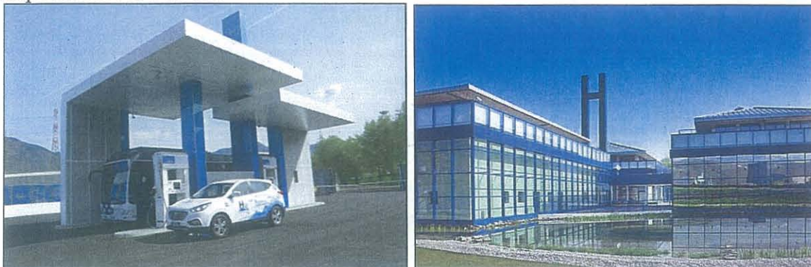
Figura 7: La stazione idrogeno di Bolzano
