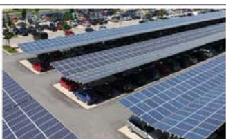
Aeroporto di Bergamo Pensilina fotovoltaica
