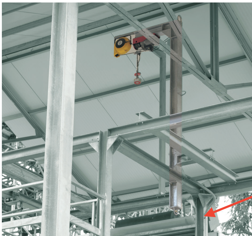
Figura 4.2.2.5-2 Attrezzatura di prova - particolare del punto di ancoraggio fisso
